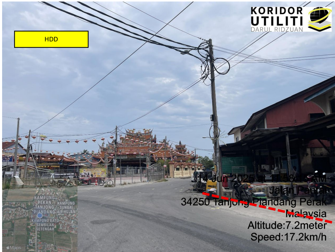
LOKASI DI JALAN PANTAI
