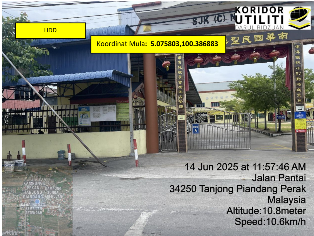
LOKASI DI JALAN PANTAI
