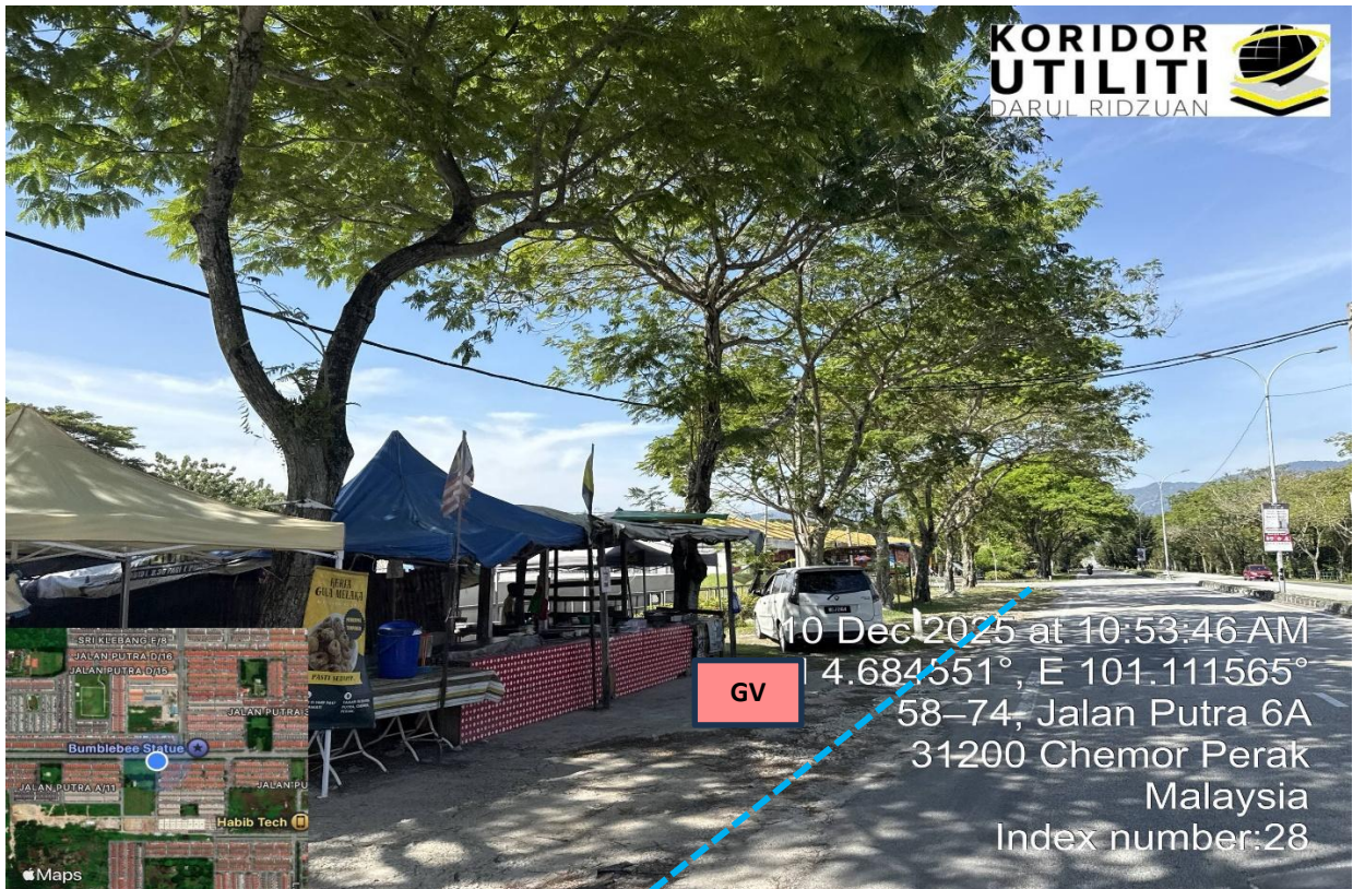
LOKASI KERJA KOREKAN TERBUKA DI HADAPAN MASJID KLEBANG PUTRA
