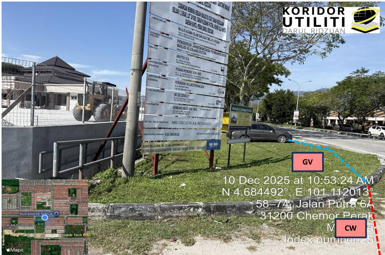
LOKASI KERJA KOREKAN TERBUKA DI JALAN PUTRA 6A
