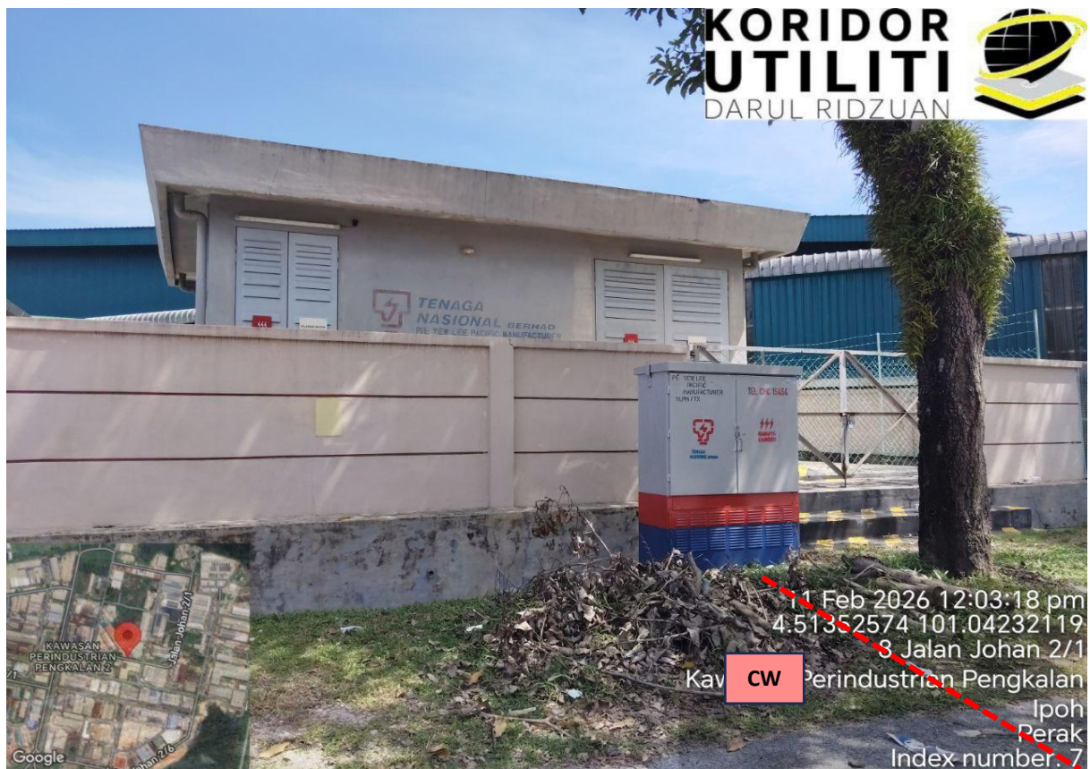
LOKASI KERJA-KERJA KOREKAN TERBUKA DI JALAN JOHAN 2/1
