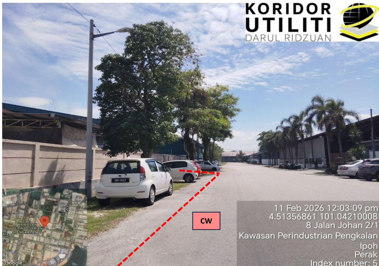
LOKASI KERJA-KERJA KOREKAN TERBUKA DI JALAN JOHAN 2/1
