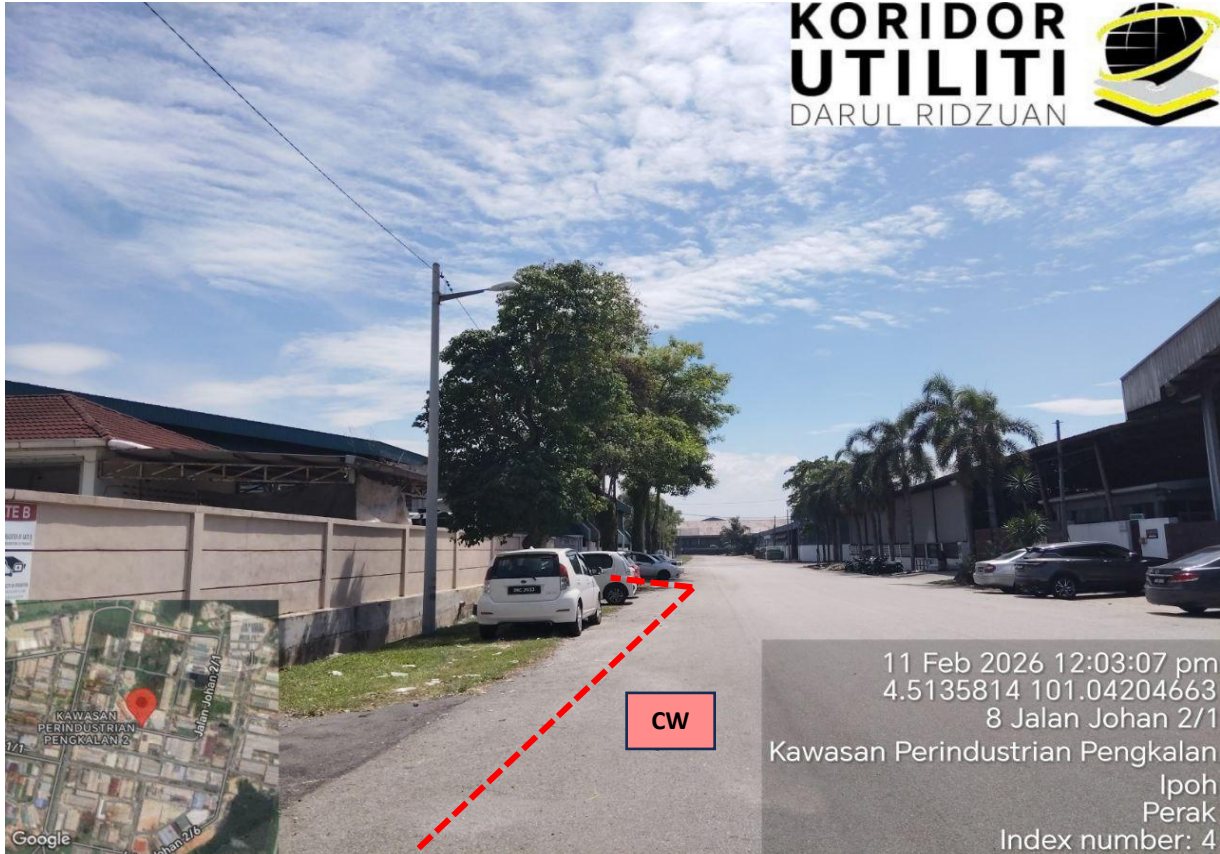
LOKASI KERJA-KERJA KOREKAN TERBUKA DI JALAN JOHAN 2/1
