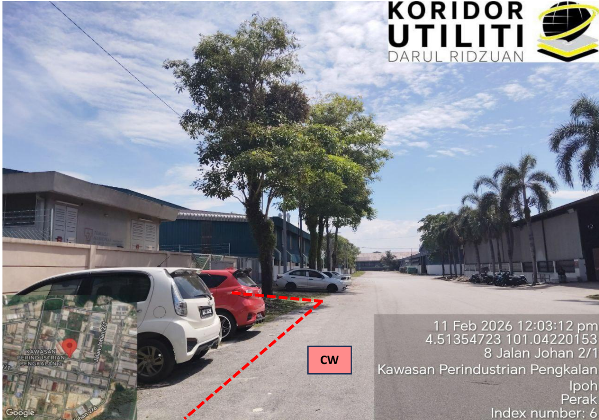
LOKASI KERJA-KERJA KOREKAN TERBUKA DI JALAN JOHAN 2/1
