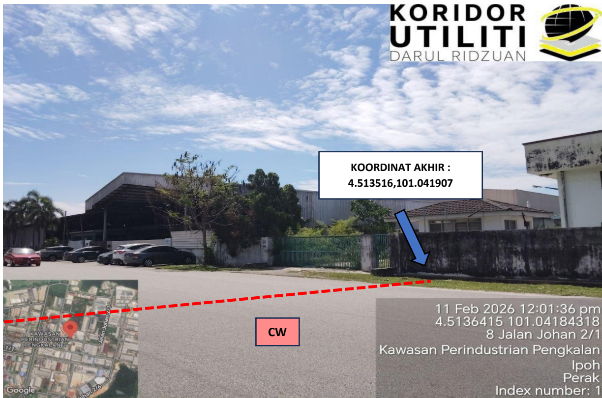
LOKASI KOORDINAT AKHIR KERJA-KERJA KOREKAN TERBUKA DI JALAN JOHAN 2/1
