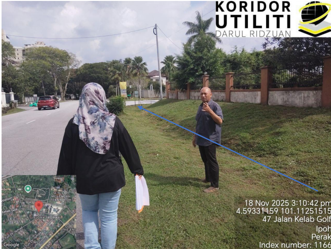
JAJARAN PEMASANGAN TIANG - PEMERIKSAAN TAPAK BERSAMA PJ MEOR MBI
