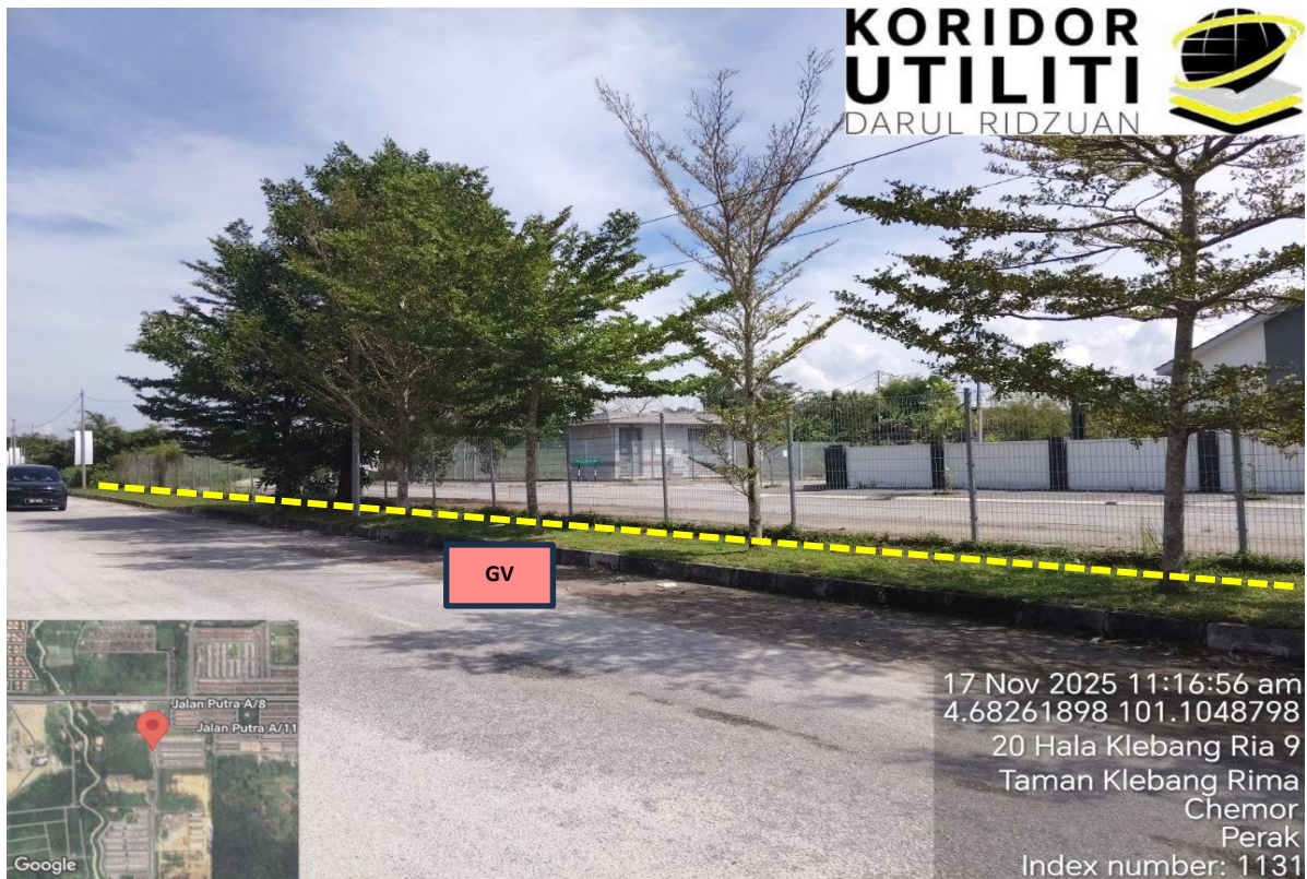
LOKASI KERJA-KERJA KOREKAN TERBUKA DI LEBUH KLEBANG PUTRA
