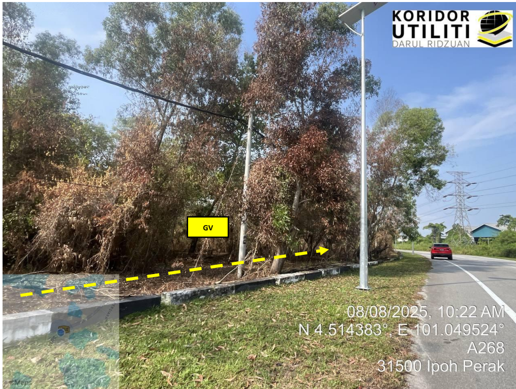
JAJARAN KOREKAN TERBUKA (GV) DI JALAN PERINDUSTRIAN PENGKALAN
