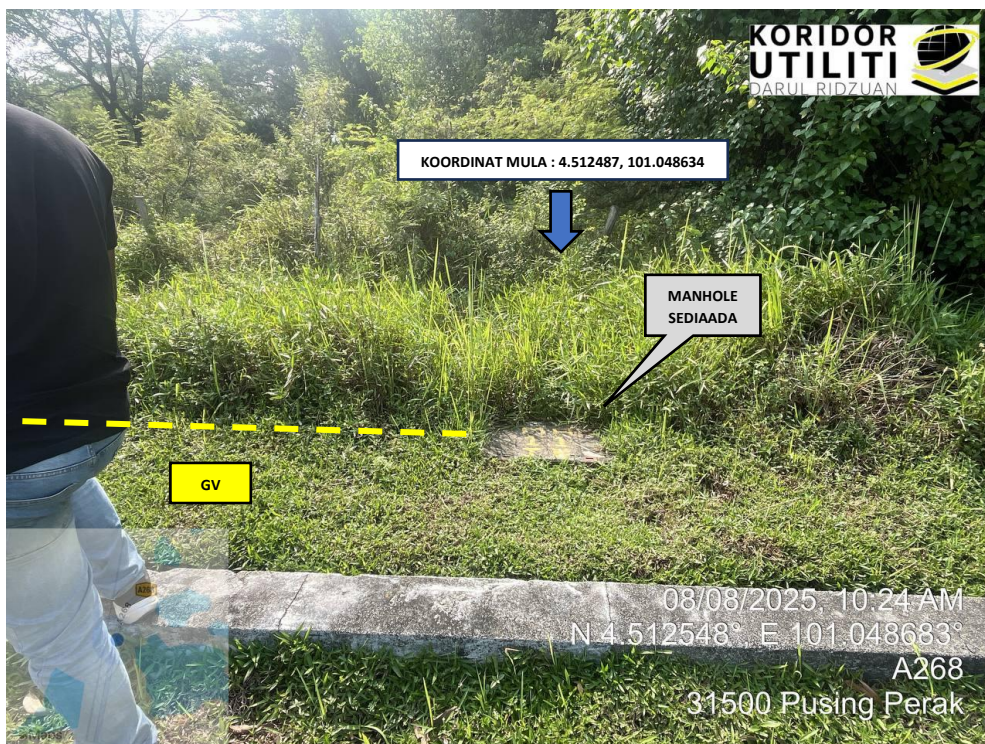
LOKASI KOORDINAT MULA KOREKAN TERBUKA DI JALAN PERINDUSTRIAN PENGKALAN (Sambungan pada manhole sedia ada)
