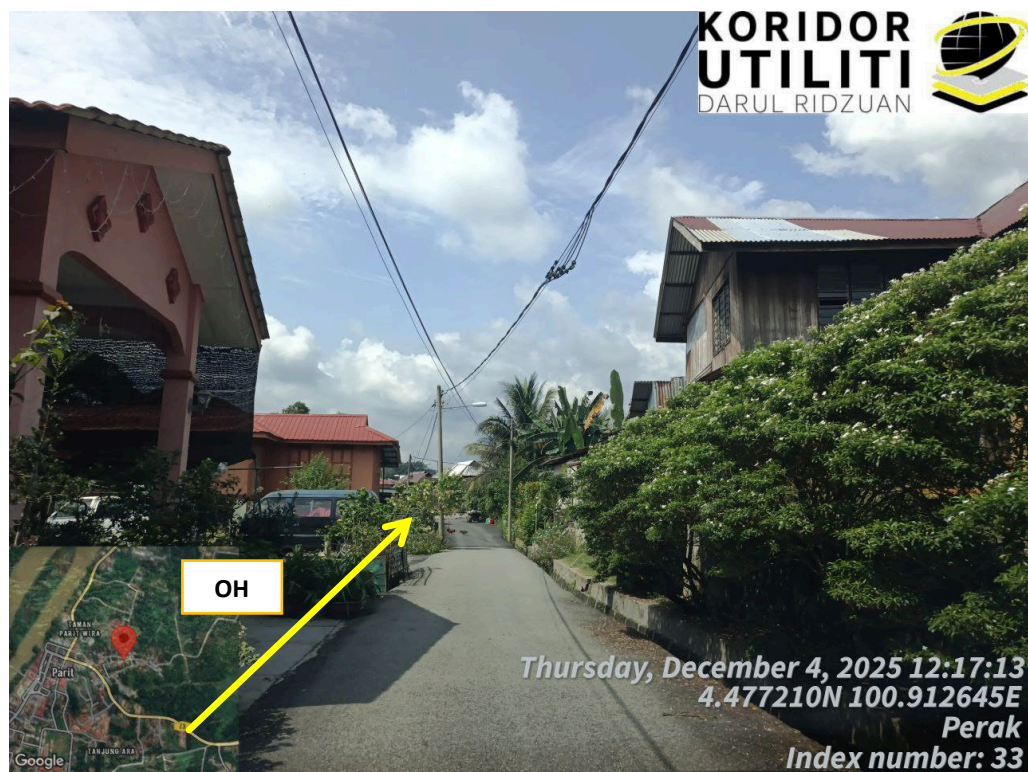
CADANGAN LALUAN BAGI KERJA PENANAMAN TIANG
