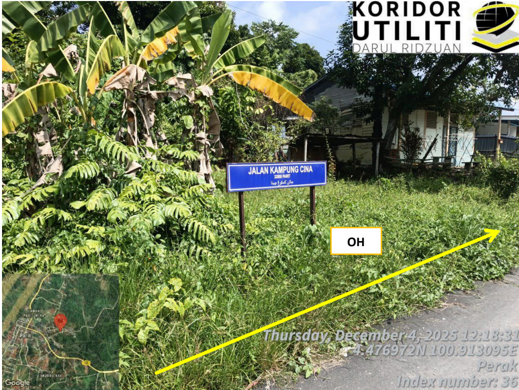
JAJARAN PENANAMAN TIANG DI JALAN KAMPUNG CINA
