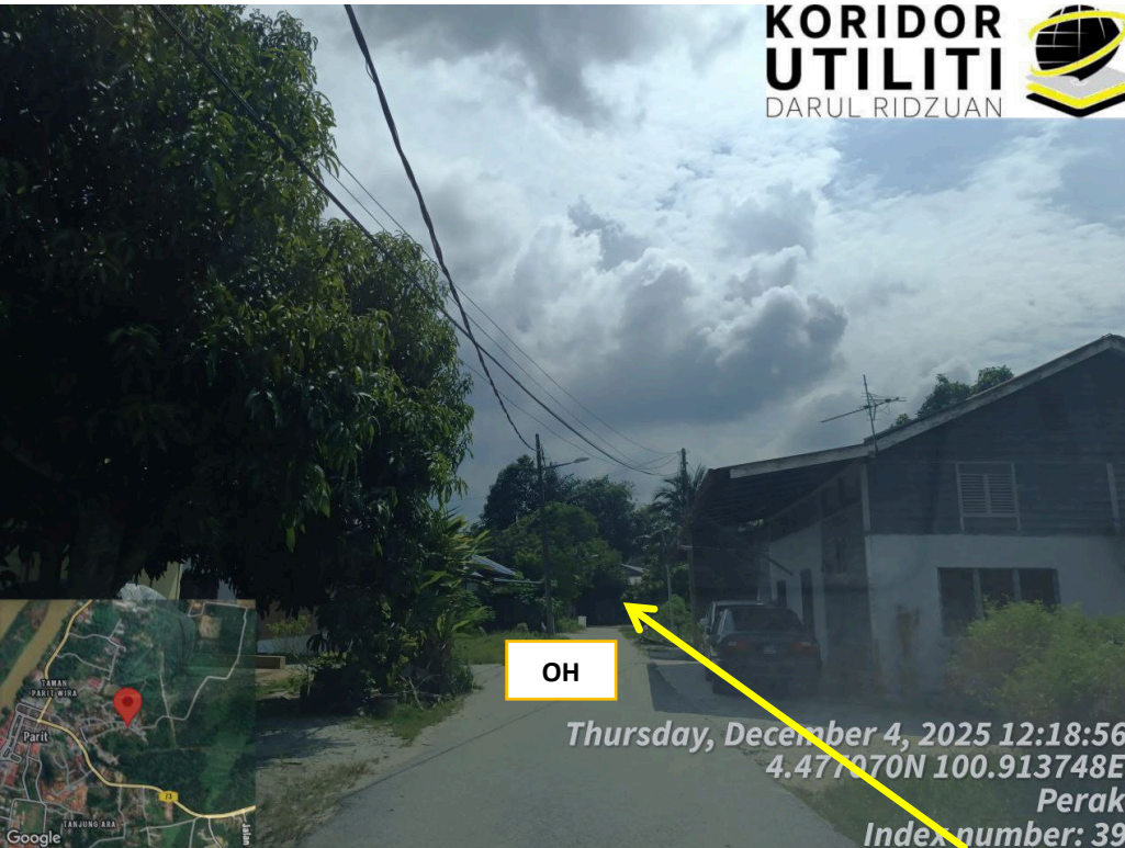
JAJARAN PENANAMAN TIANG DI JALAN KAMPUNG CINA
