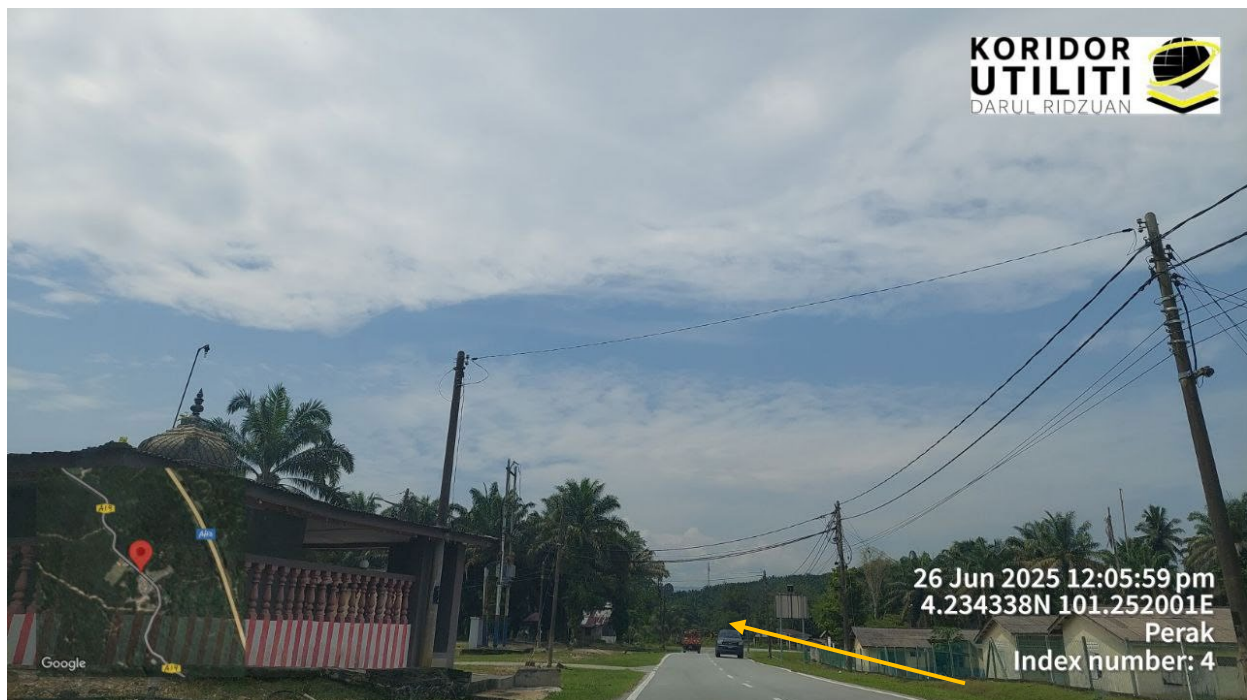
HDD DI JALAN JKR
