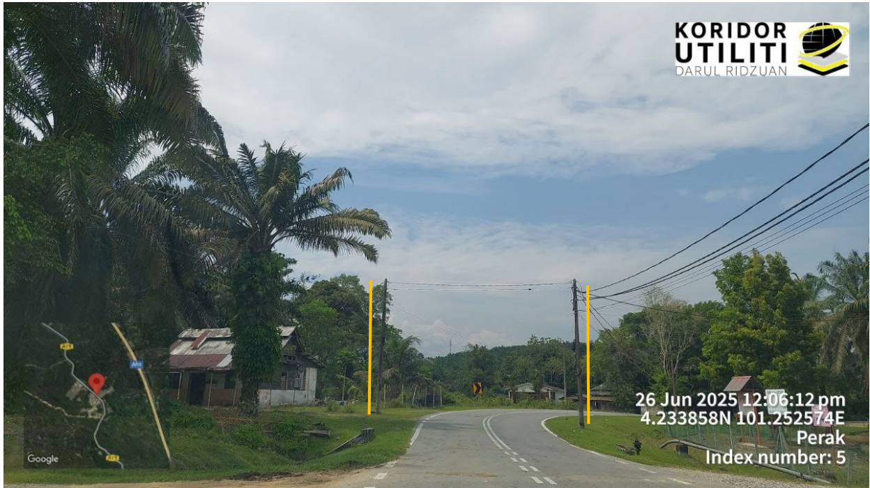
JKR MEMBENARKAN CADANGAN TIANG CROSSING OVERHEAD
