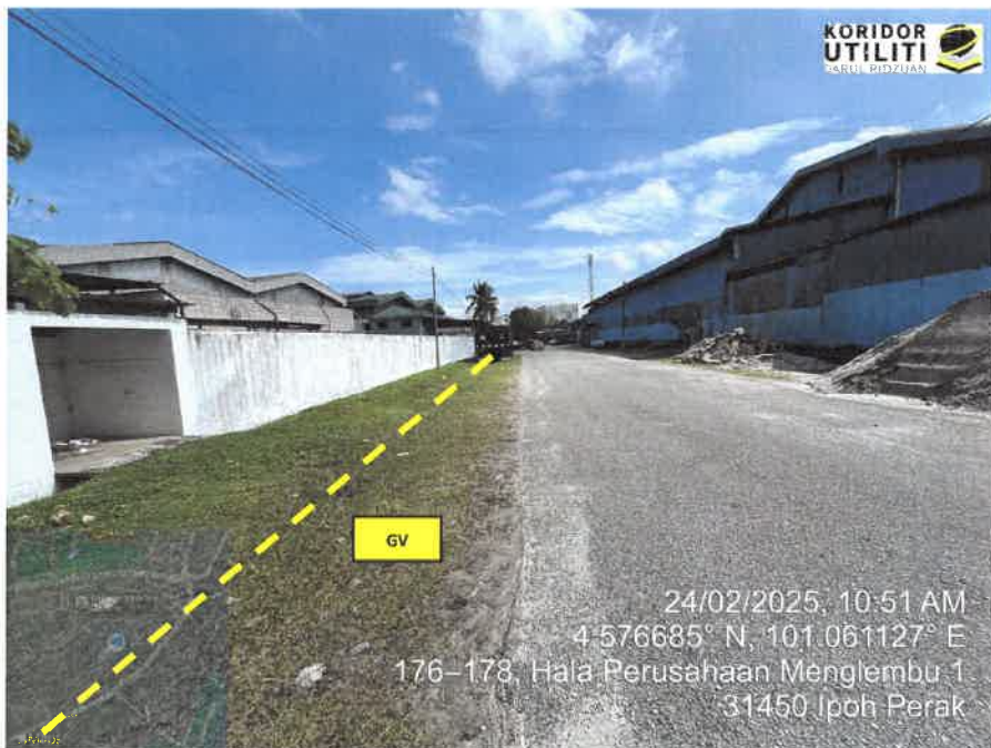
JAJARAN KOREKAN TERBUKA JALAN TIDAK BERTURAP DI HALA PERUSAHAAN MENGLEMBU 1
