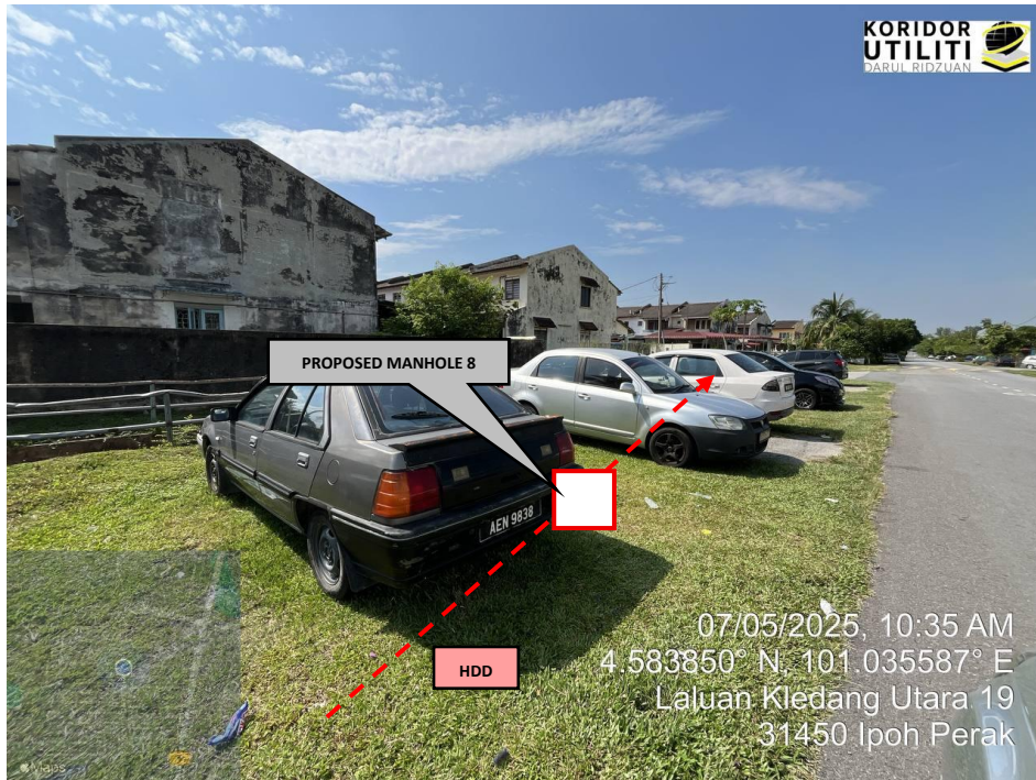
JAJARAN KERJA HDD DI LALUAN KLEDANG UTARA 19
