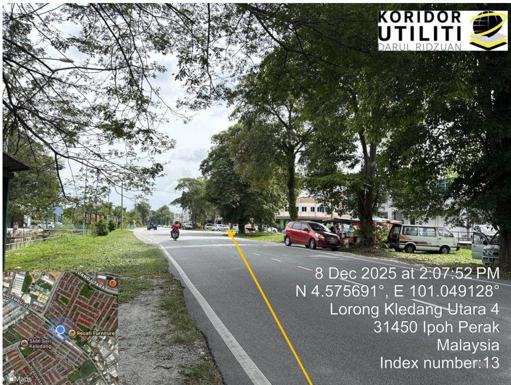
JAJARAN KERJA HDD – HALA PERUSAHAAN MENGLEMBU 13
