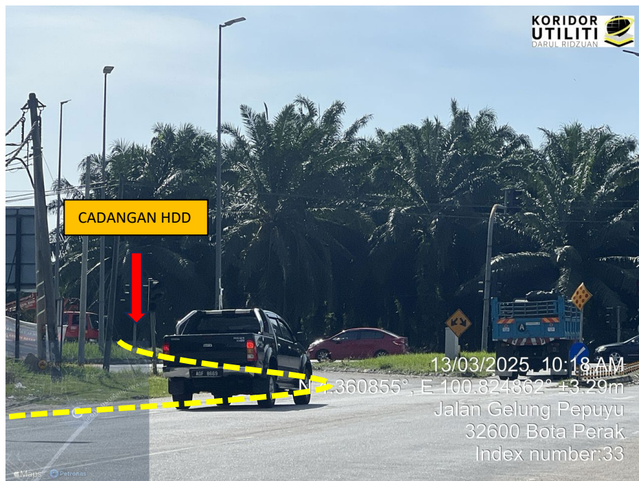
GAMBAR 3: JALAN LEBUHRAYA LUMUT – IPOH KAEDAH HDD
