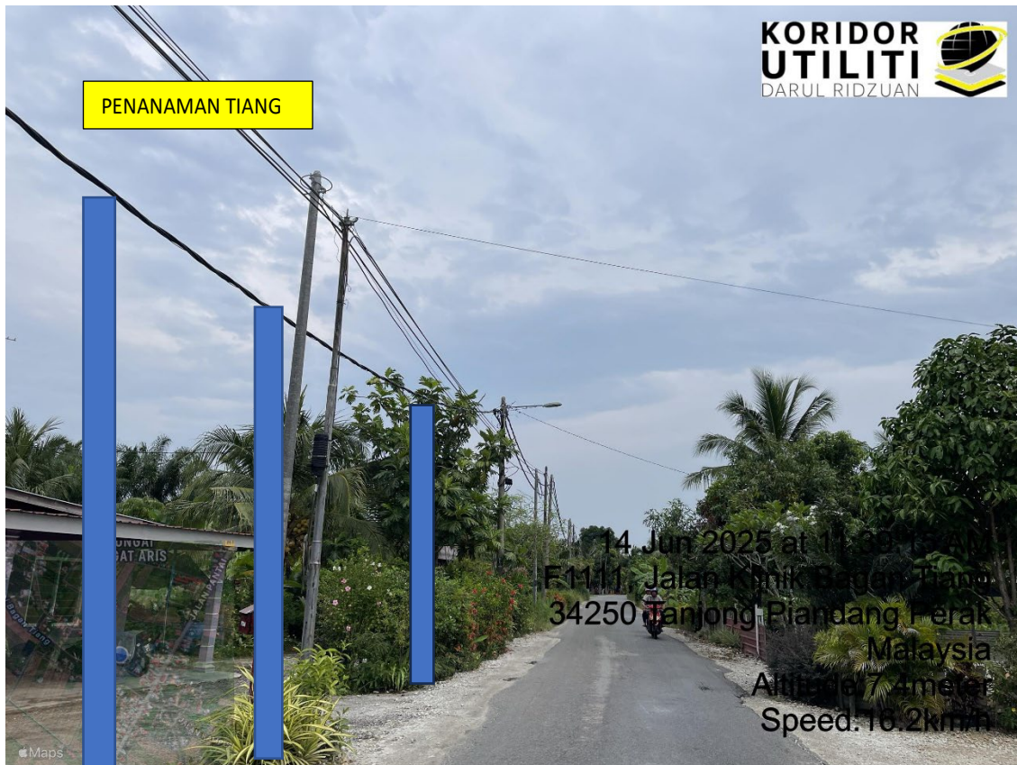
LOKASI DI JALAN KAMPUNG KUALA BAGAN TIANG
