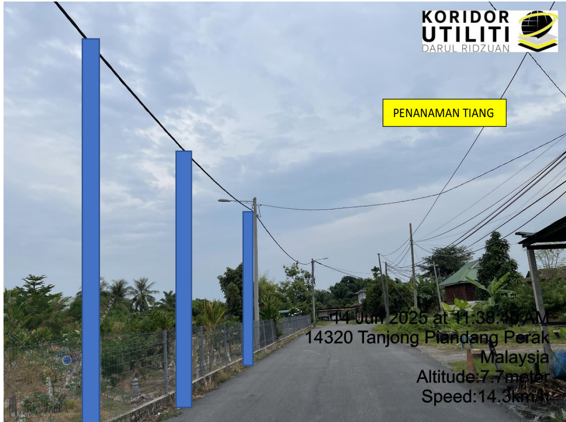
LOKASI DI JALAN KAMPUNG KUALA BAGAN TIANG
