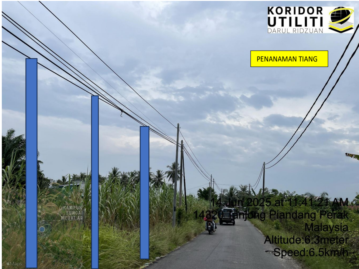
LOKASI DI JALAN KAMPUNG KUALA BAGAN TIANG
