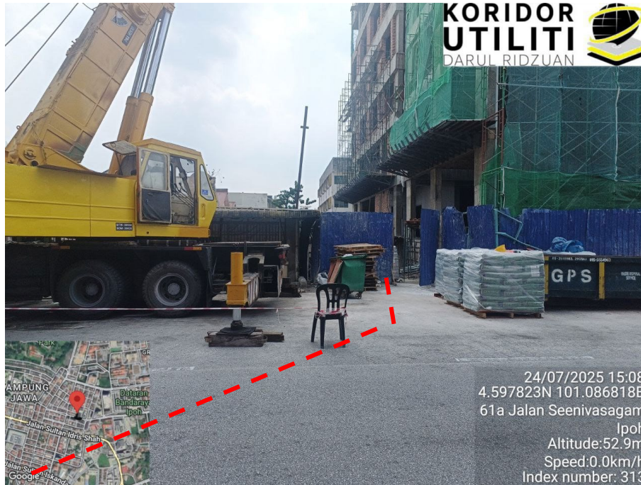
JAJARAN KOREKAN TERBUKA DI JALAN SEENIVASAGAM
