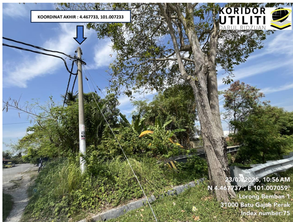
KOORDINAT AKHIR KERJA PENANAMAN TIANG DI LORONG BEMBAN 1
