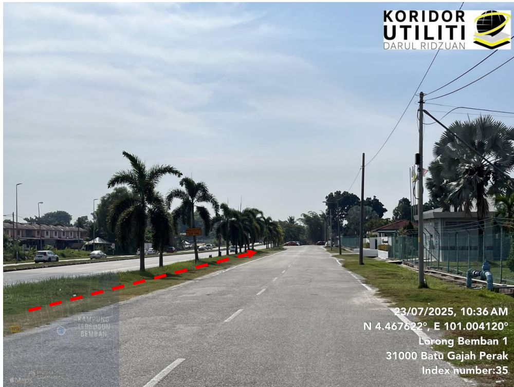
JAJARAN KERJA PENANAMAN TIANG DI LORONG BEMBAN 1
