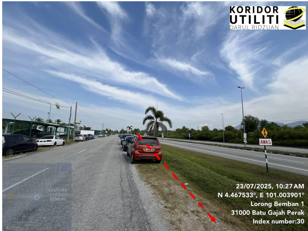
JAJARAN KERJA PENANAMAN TIANG DI LORONG BEMBAN 1
