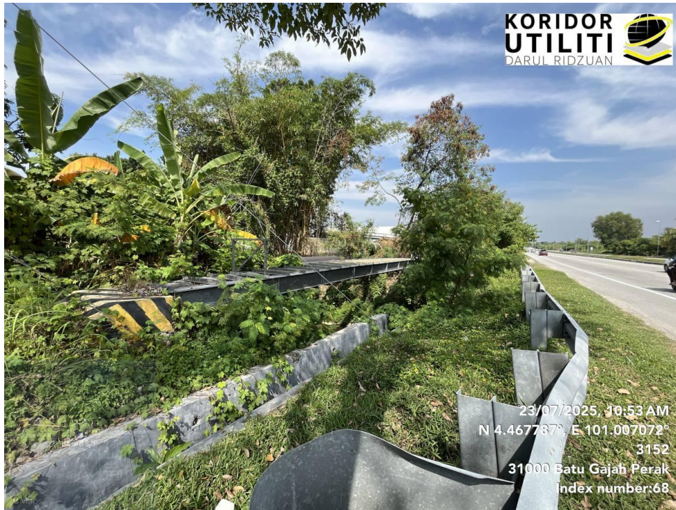
JAJARAN KERJA PENANAMAN TIANG DI LORONG BEMBAN 1
