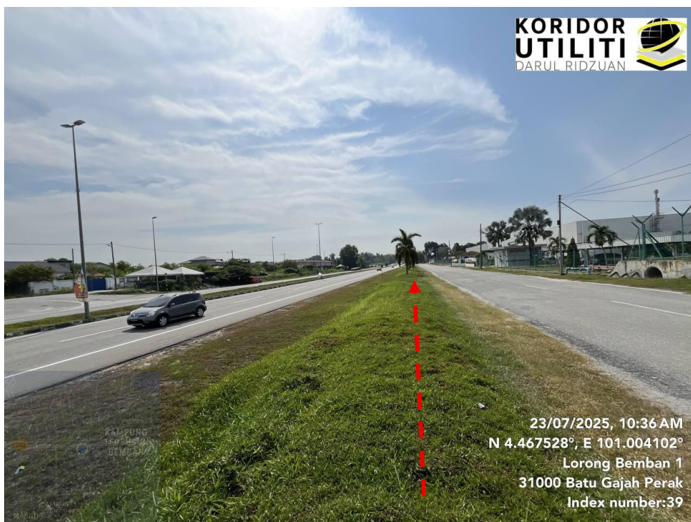
JAJARAN KERJA PENANAMAN TIANG DI LORONG BEMBAN 1
