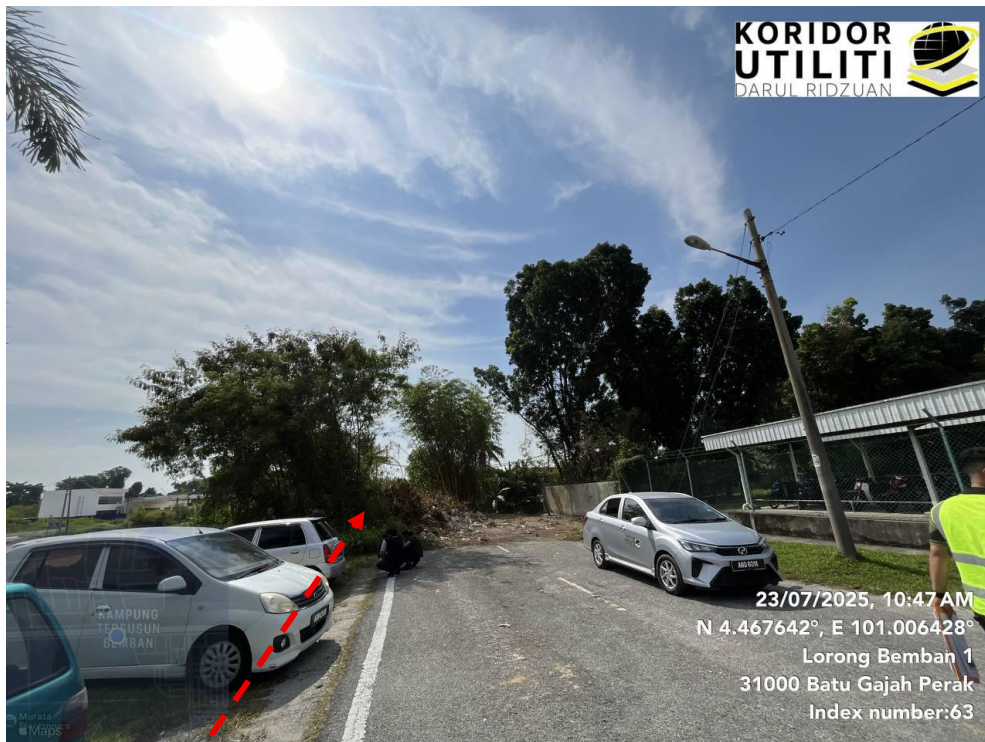
JAJARAN KERJA PENANAMAN TIANG DI LORONG BEMBAN 1
