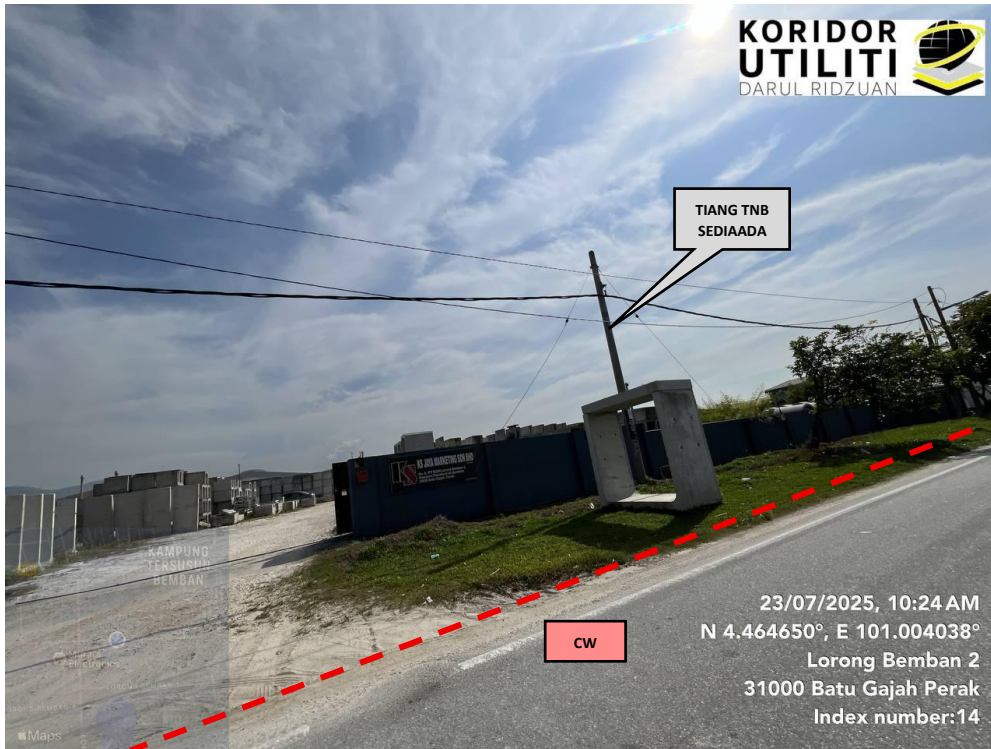
JAJARAN KERJA KOREKAN TERBUKA DAN PENGALIHAN TIANG DI LORONG BEMBAN 2
