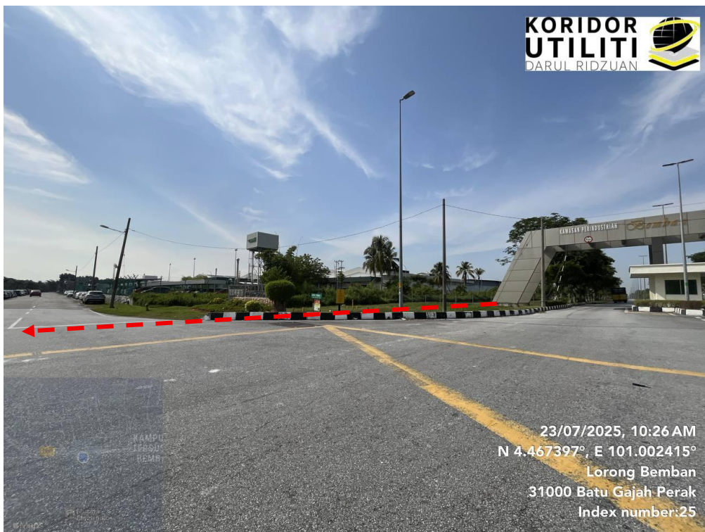
JAJARAN KERJA PENANAMAN TIANG DI JALAN RPT SIMPANG PUTEH – LORONG BEMBAN 1
