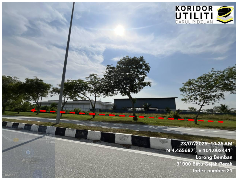
JAJARAN KERJA PENANAMAN TIANG DI LORONG BEMBAN 2 – JALAN RPT SIMPANG PUTEH
