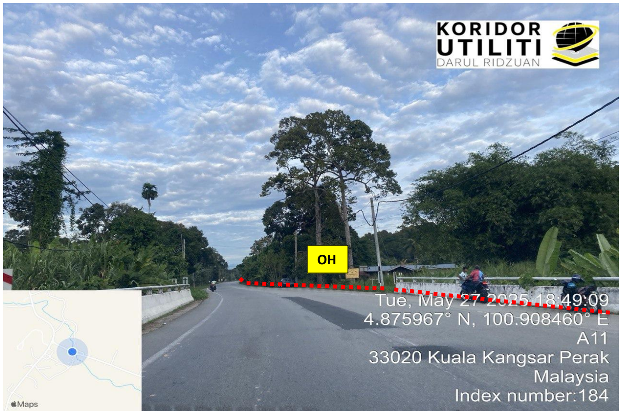
LOKASI DI JALAN A11
