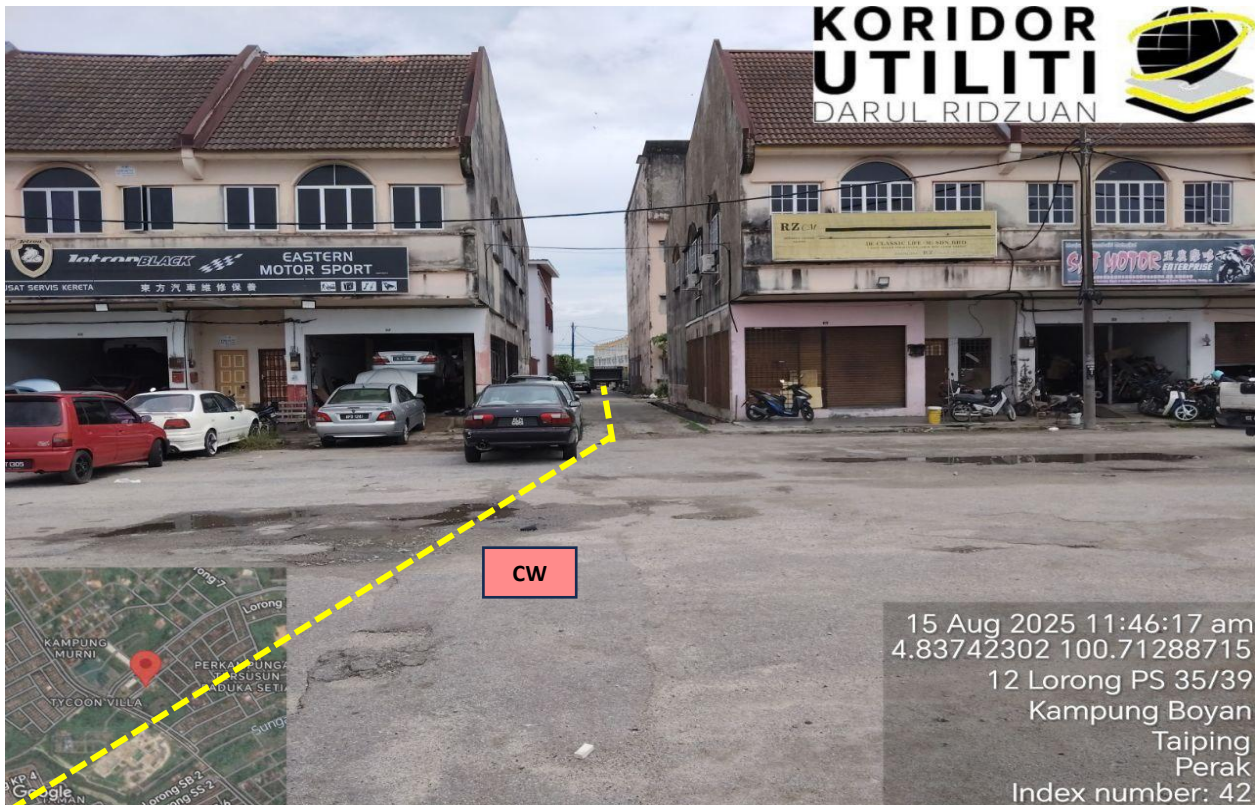
LOKASI KERJA-KERJA KOREKAN TERBUKA DI LORONG PS 35/39
