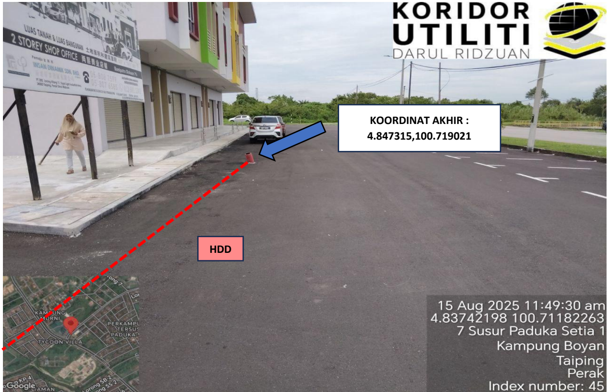
LOKASI KOORDINAT AKHIR KERJA-KERJA HDD DI SUSUR PADUKA SETIA 1
