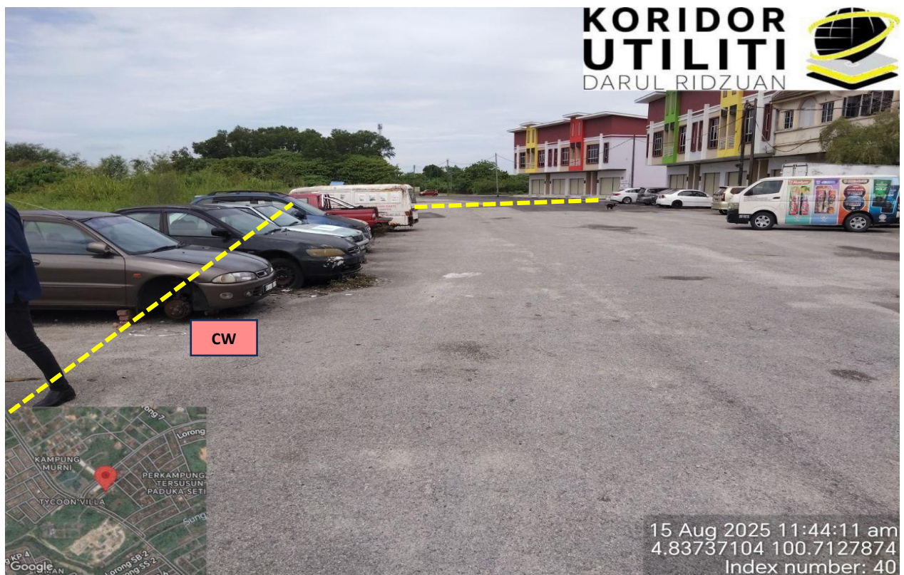
LOKASI KERJA-KERJA KOREKAN TERBUKA DI LORONG PS 35/39
