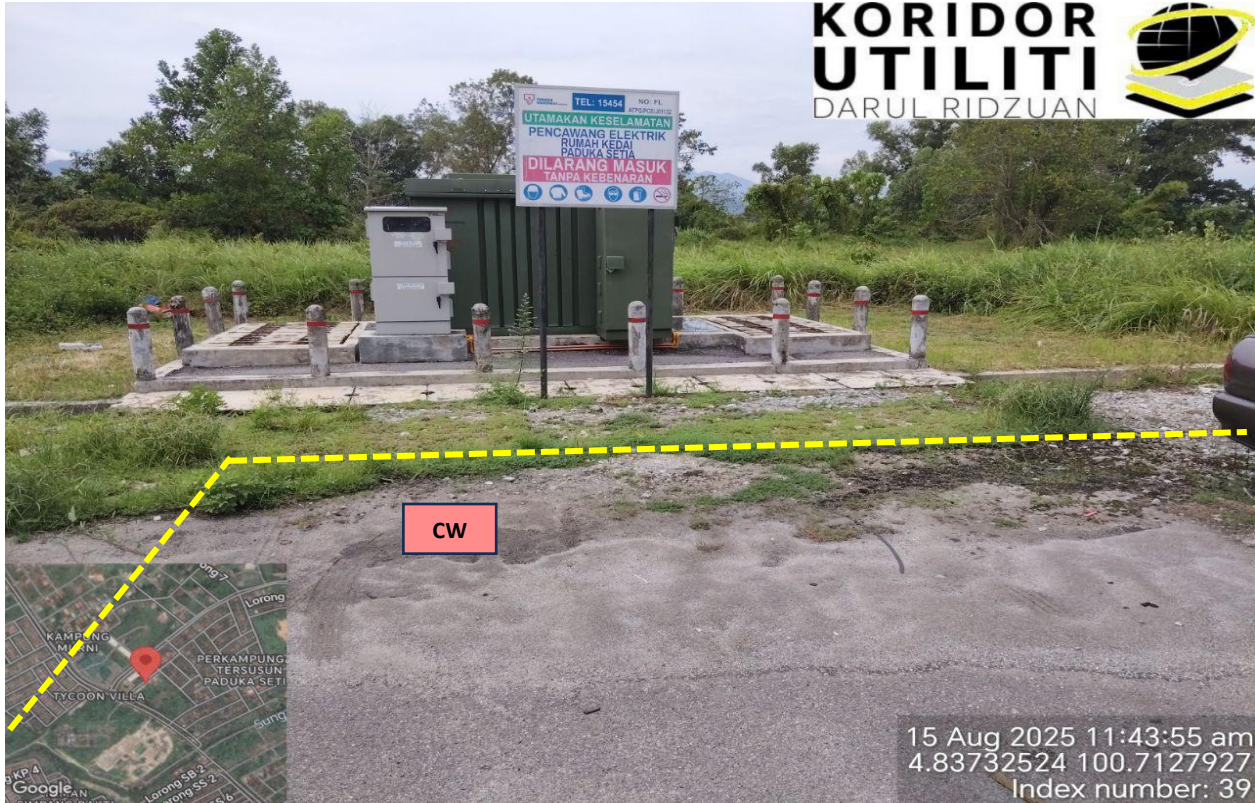
LOKASI KERJA-KERJA KOREKAN TERBUKA DI LORONG PS 35/39
