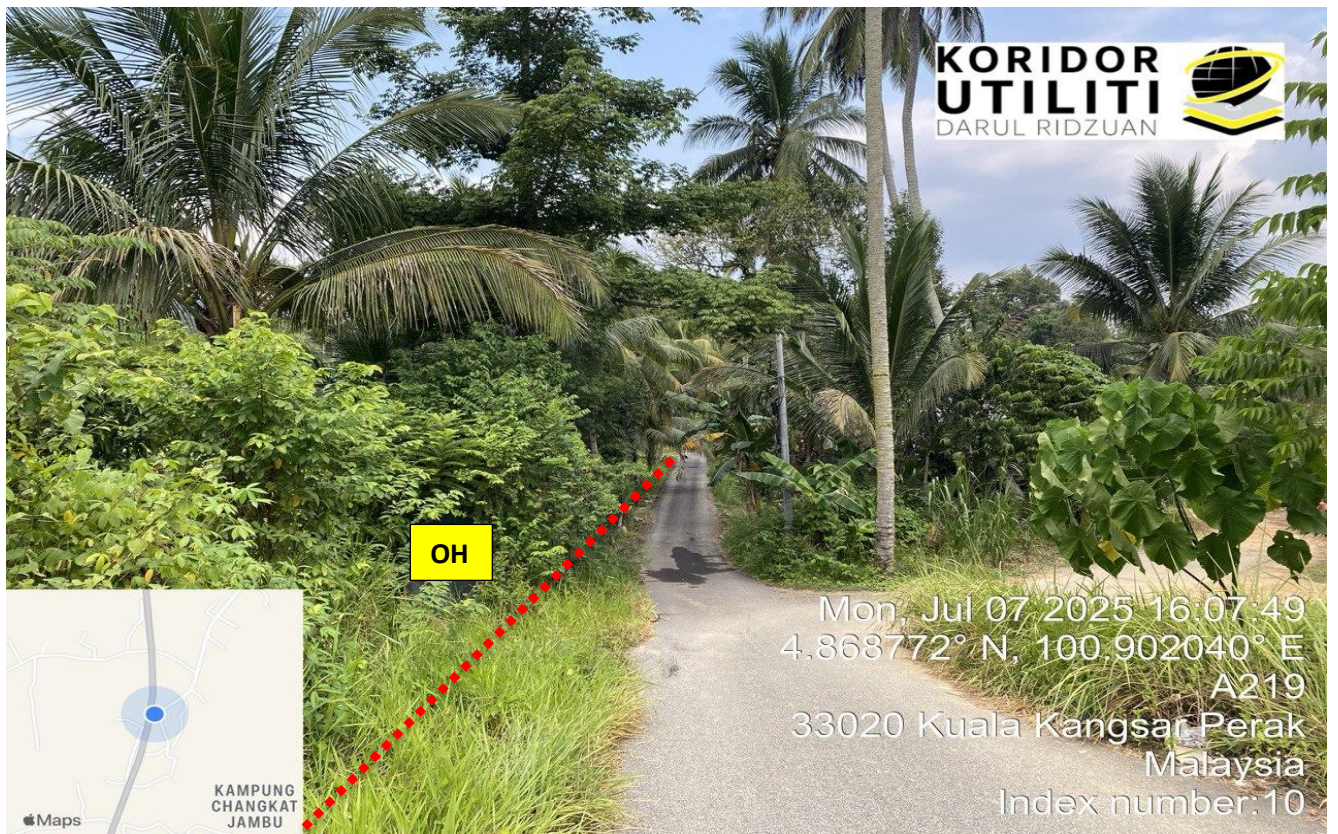
LOKASI DI JAJARAN PEMASANGAN UTILITI JALAN PDT
