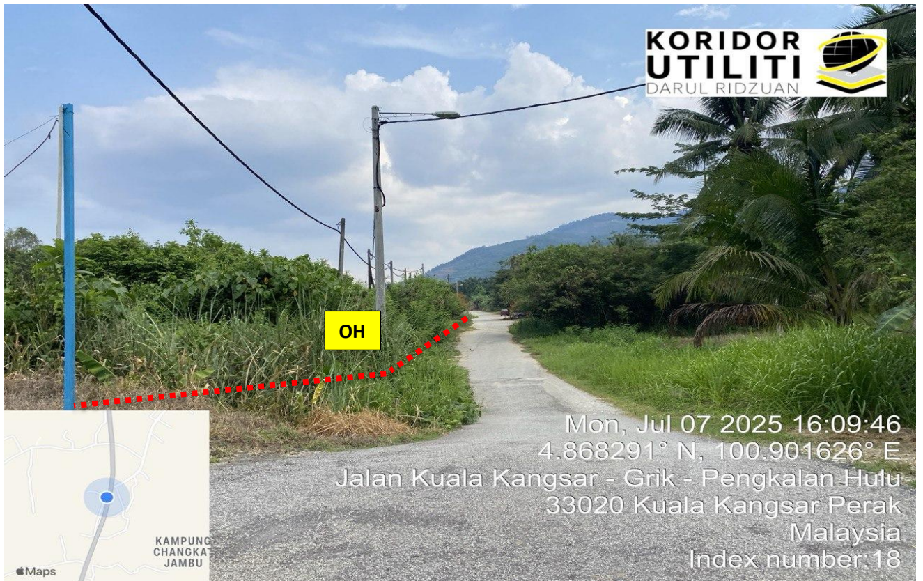
LOKASI DI JAJARAN PEMASANGAN UTILITI JALAN PDT
