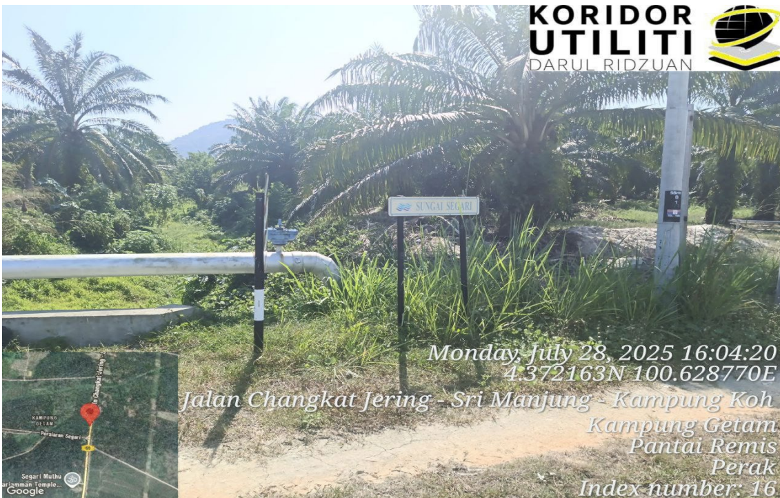
LOKASI KERJA DI SUNGAI SEGARI (JPS)
