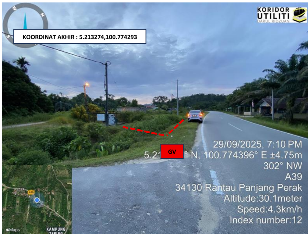
KOORDINAT AKHIR – CADANGAN KOREKAN JALAN TIDAK BERTURAP DAN PIT ( BERSAMBUNG KE P/E ULU MENGKUANG 3 )
