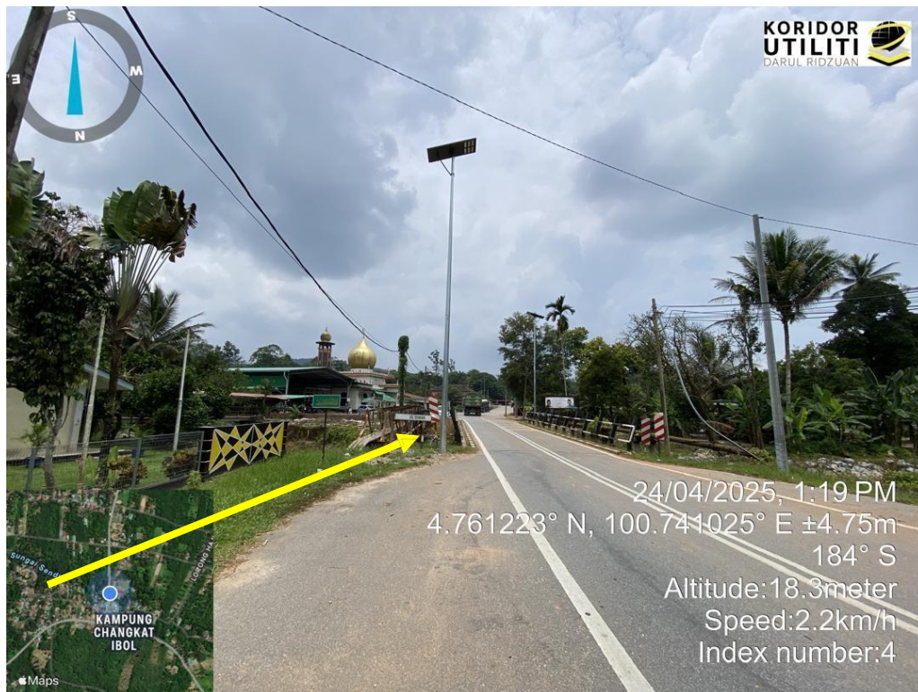
LALUAN HDD DI JAMBATAN SUNGAI SENDUK
