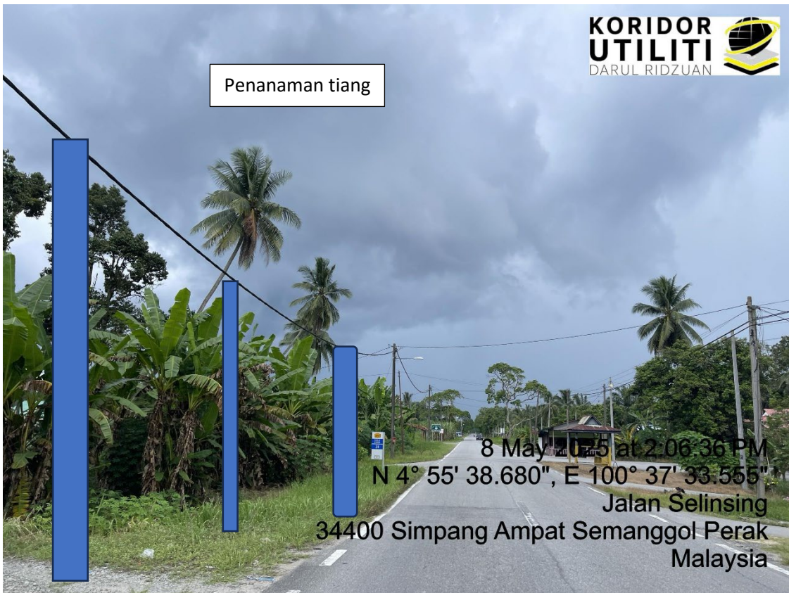
LOKASI DI JALAN SELINSING
