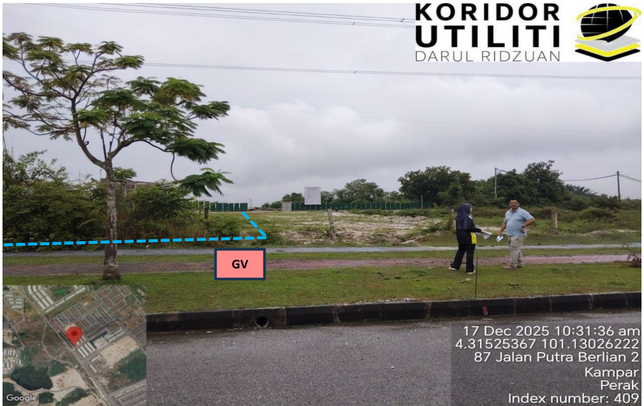
LOKASI KERJA KOREKAN TERBUKA DI JALAN DISNEY AVE KE KAWASAN PPROJEK
