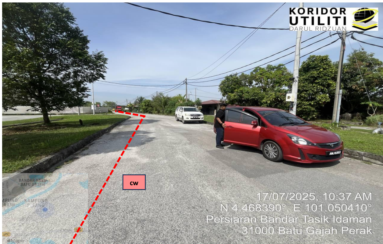
LOKASI KERJA-KERJA KOREKAN TERBUKA DI PERSIARAN BANDAR TASIK SELATAN
