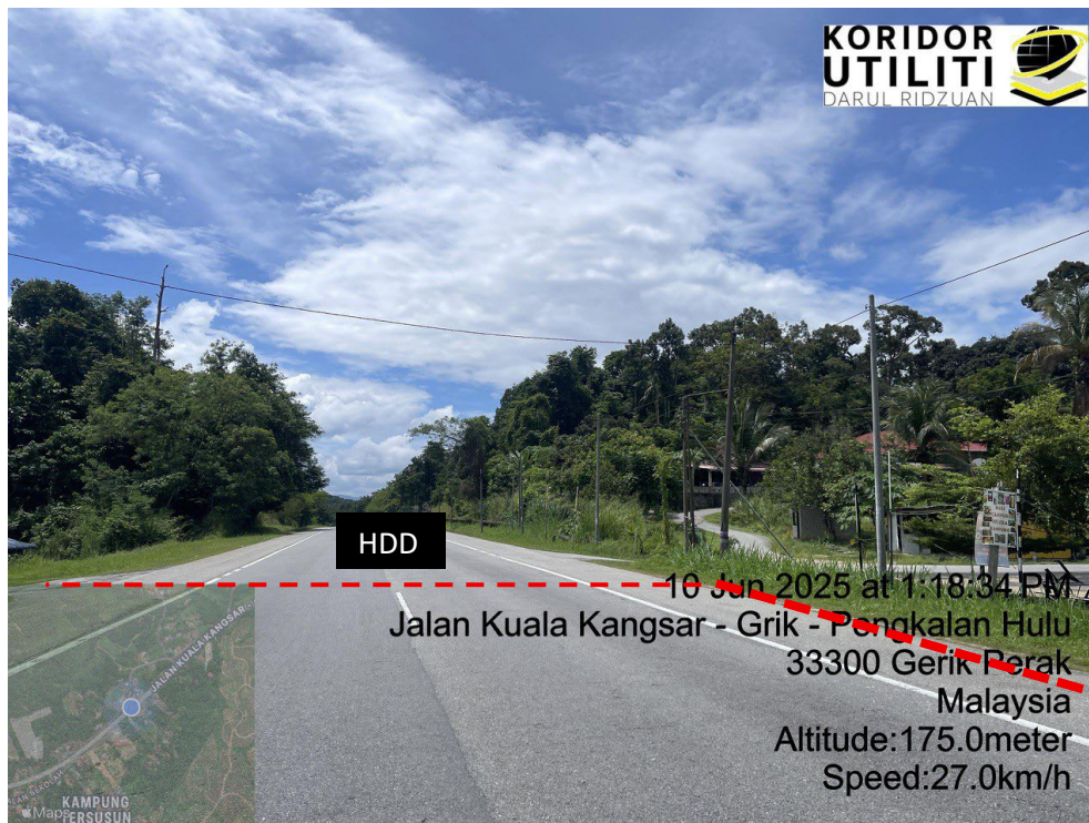
LOKASI DI JALAN KUALA KANGSAR – GRIK – PENGKALAN HULU
