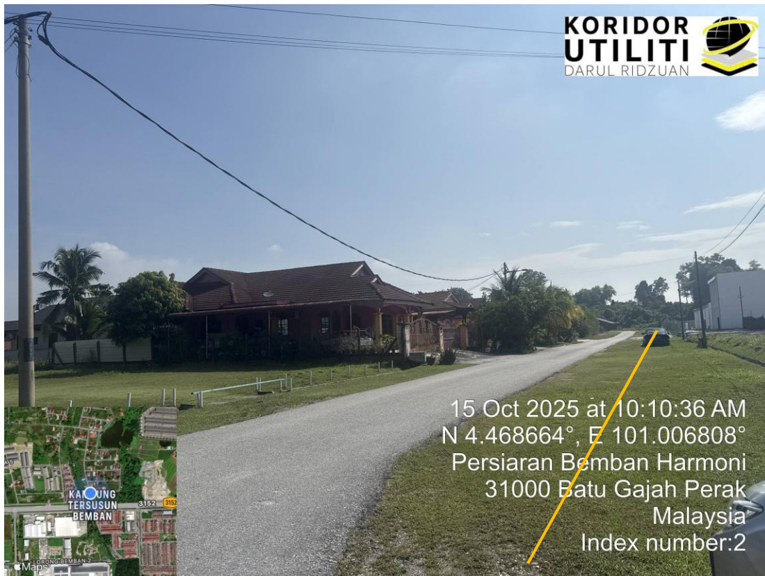
KOREKAN TERBUKA DI BAHU JALAN (GV)
