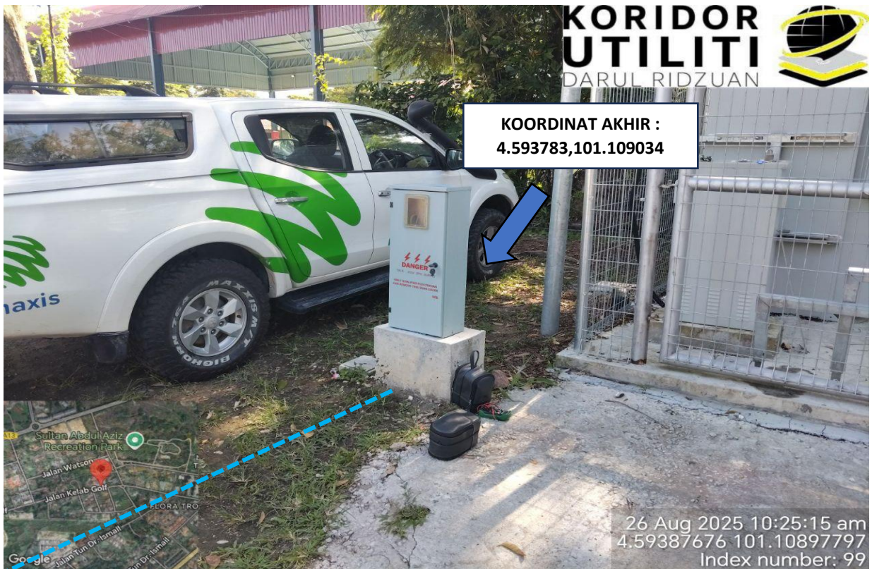
LOKASI KOORDINAT AKHIR KERJA KOREKAN TERBUKA DI JALAN PERSENDIRIAN
