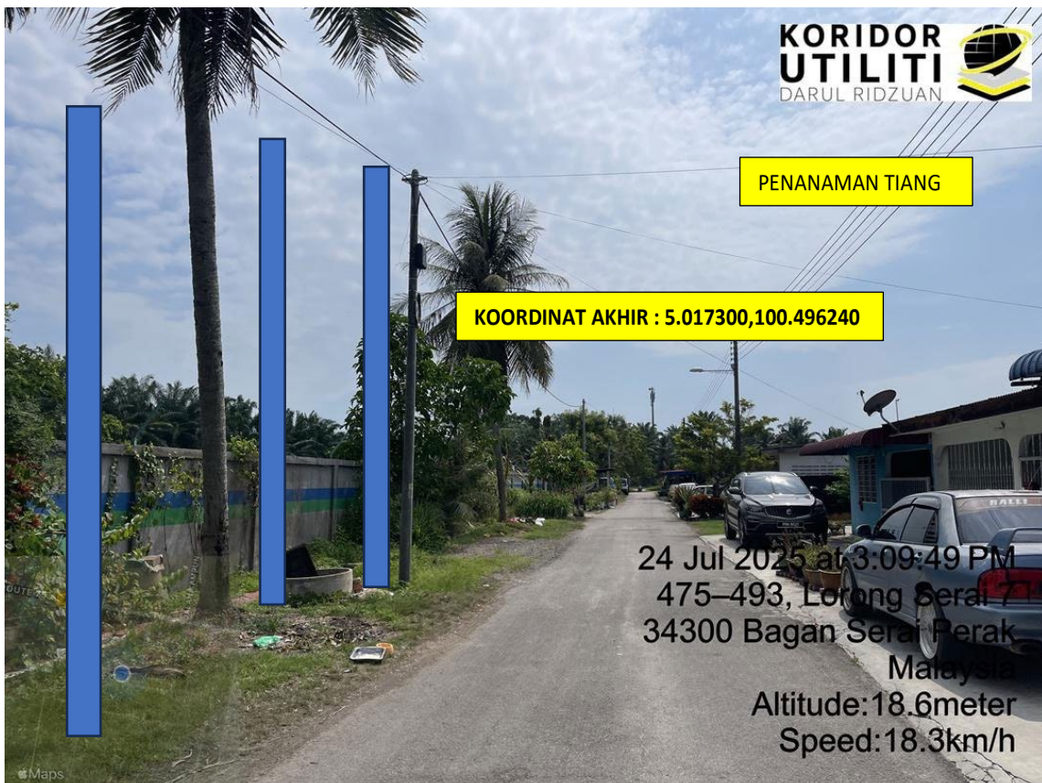
LOKASI DI JALAN TAMAN SERAI JAYA
