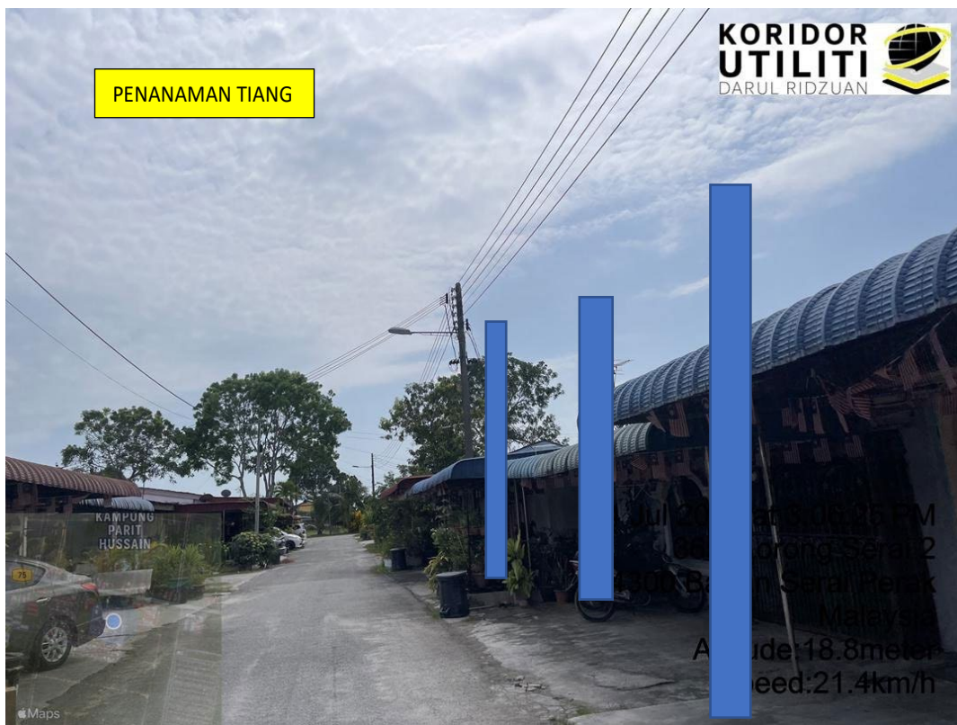
LOKASI DI JALAN TAMAN SERAI JAYA
