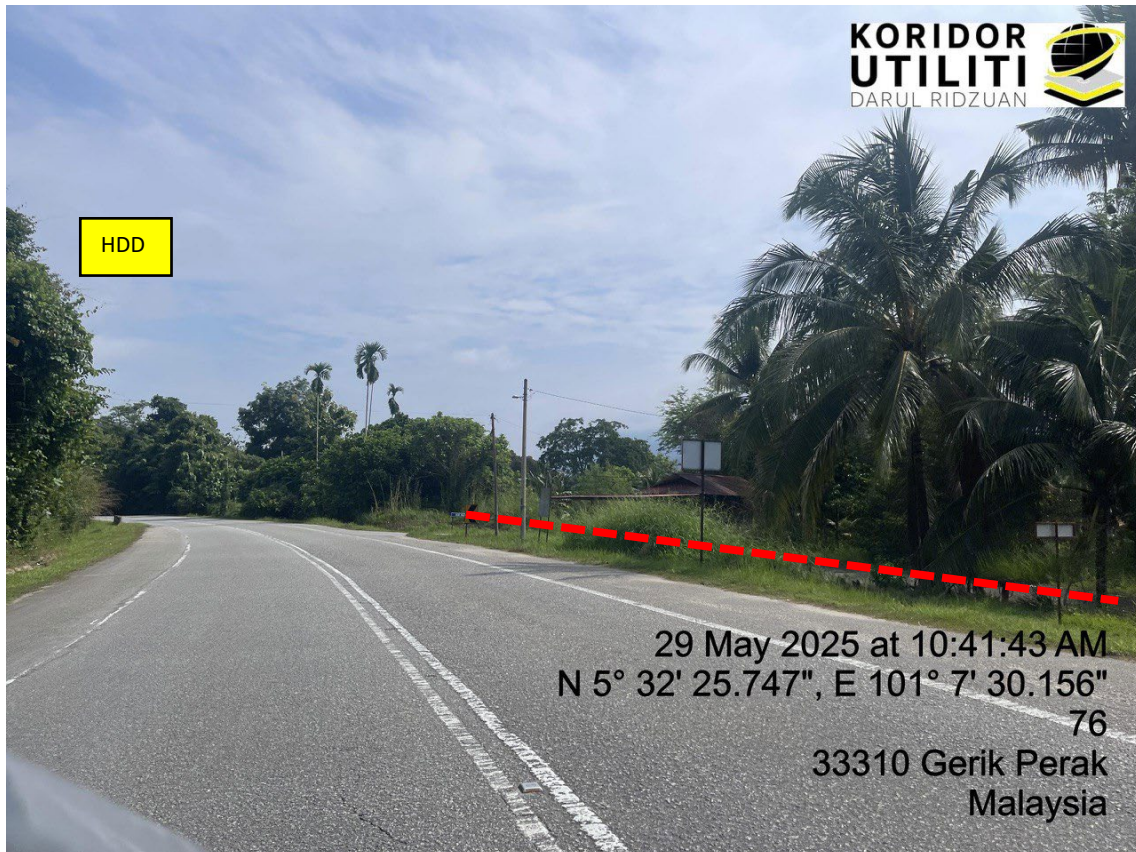
LOKASI DI JALAN KUALA KANGSAR - BALING
