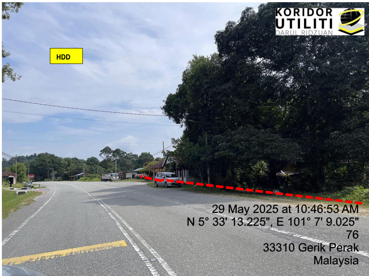
LOKASI DI JALAN KUALA KANGSAR – BALING
