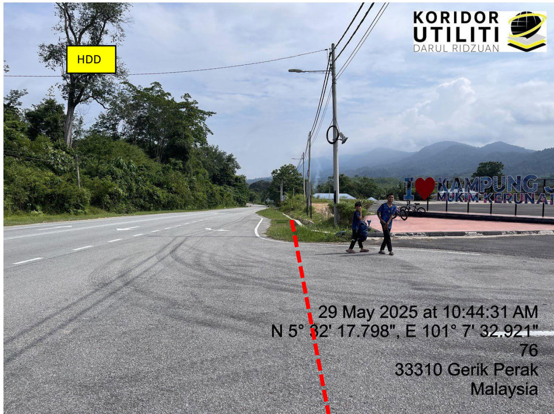
LOKASI DI JALAN KUALA KANGSAR - BALING
