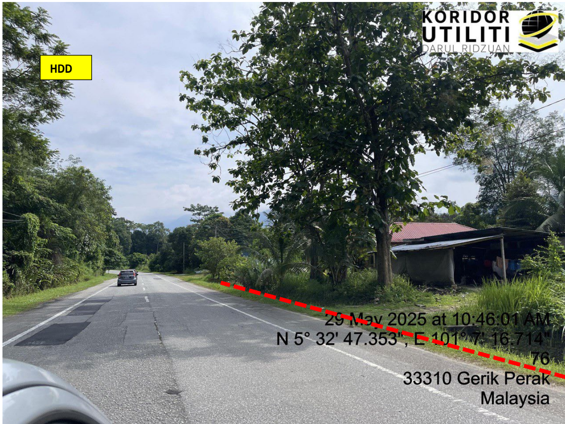
LOKASI DI JALAN KUALA KANGSAR - BALING
