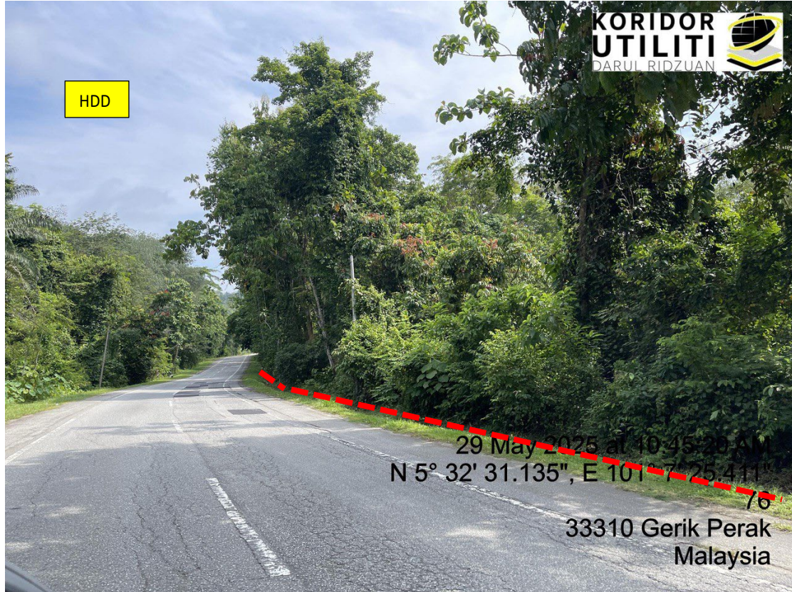
LOKASI DI JALAN KUALA KANGSAR - BALING
