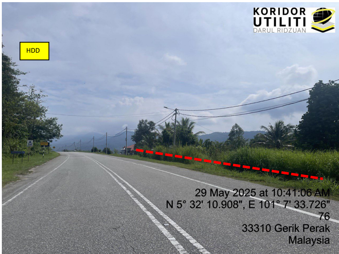
LOKASI DI JALAN KUALA KANGSAR - BALING
