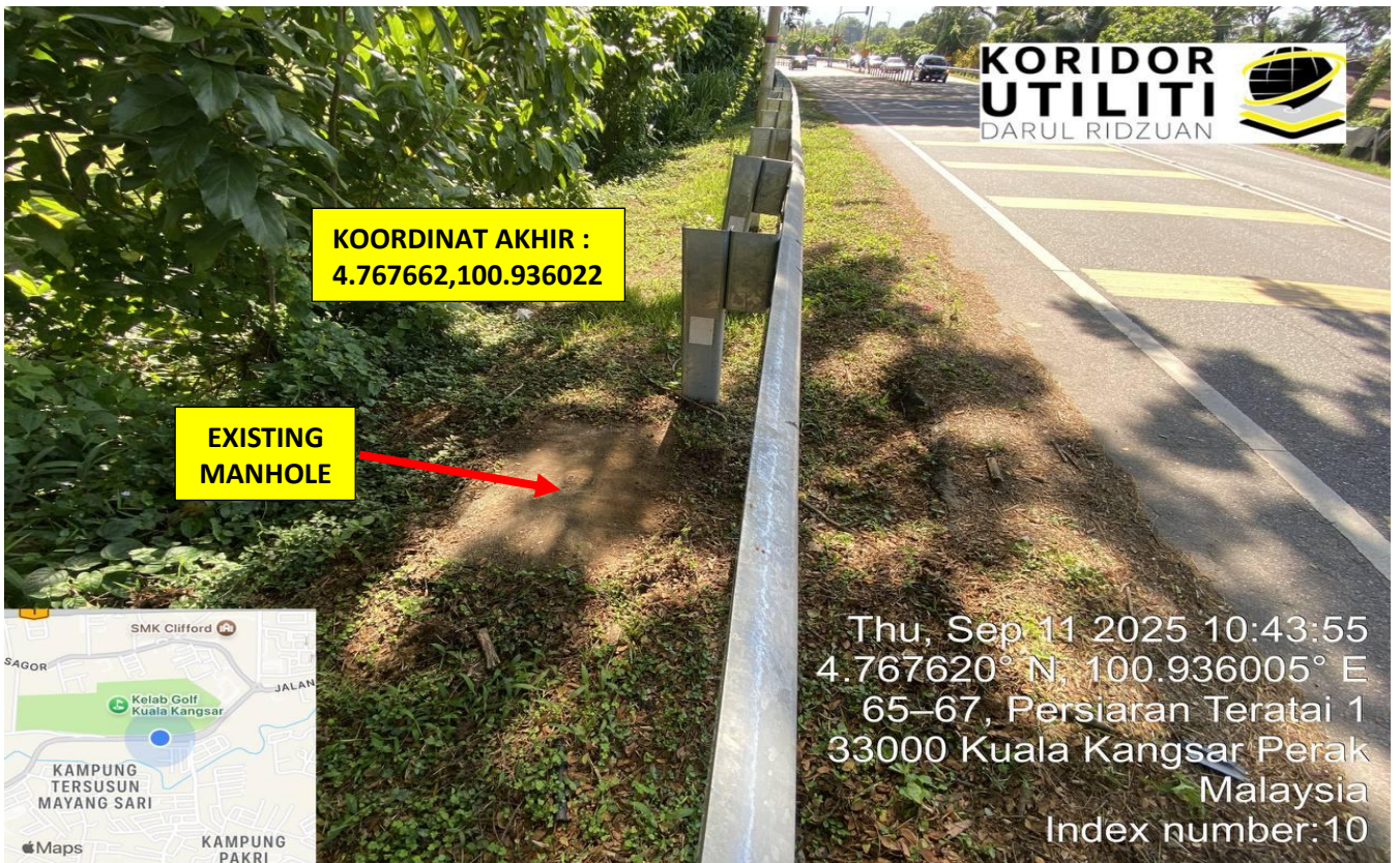
LOKASI DI JALAN SULTAN ISKANDAR SHAH (A003)
