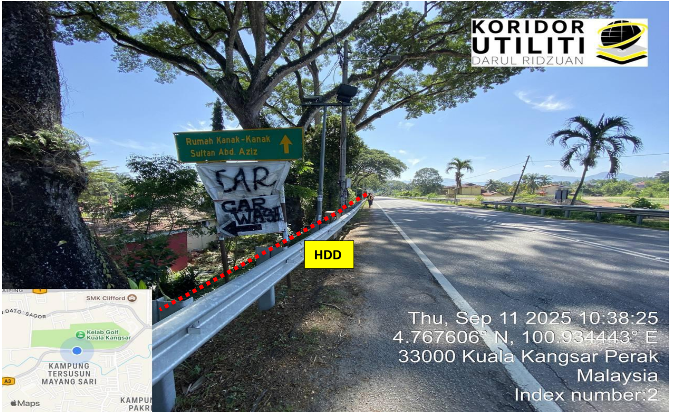
LOKASI DI JALAN SULTAN ISKANDAR SHAH (A003)
