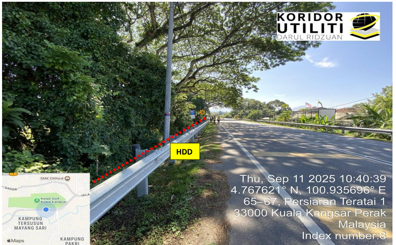
LOKASI DI JALAN SULTAN ISKANDAR SHAH (A003)
