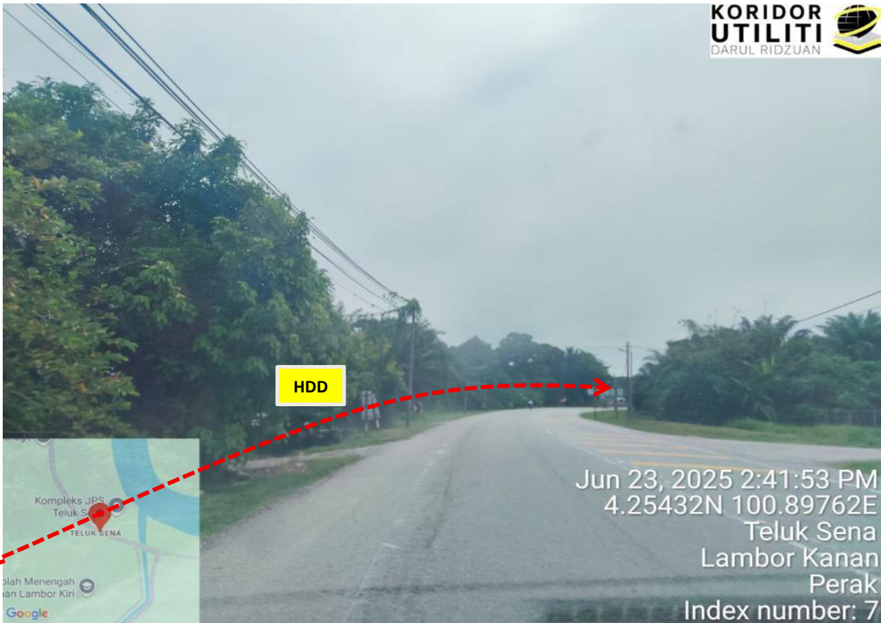
JALAN BOTA KIRI – JAMBATAN DATO SAGOR (A018)
