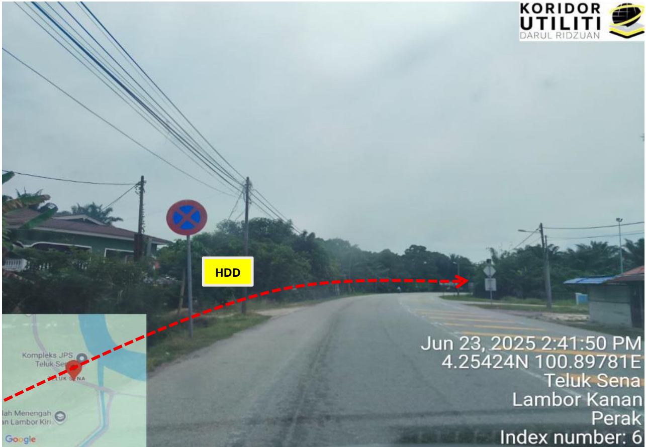
JALAN BOTA KIRI – JAMBATAN DATO SAGOR (A018)
