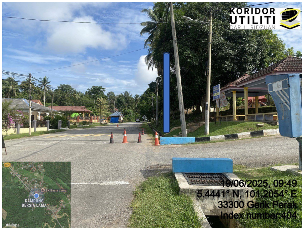
LOKASI DI JALAN SK BASIA LAMA
