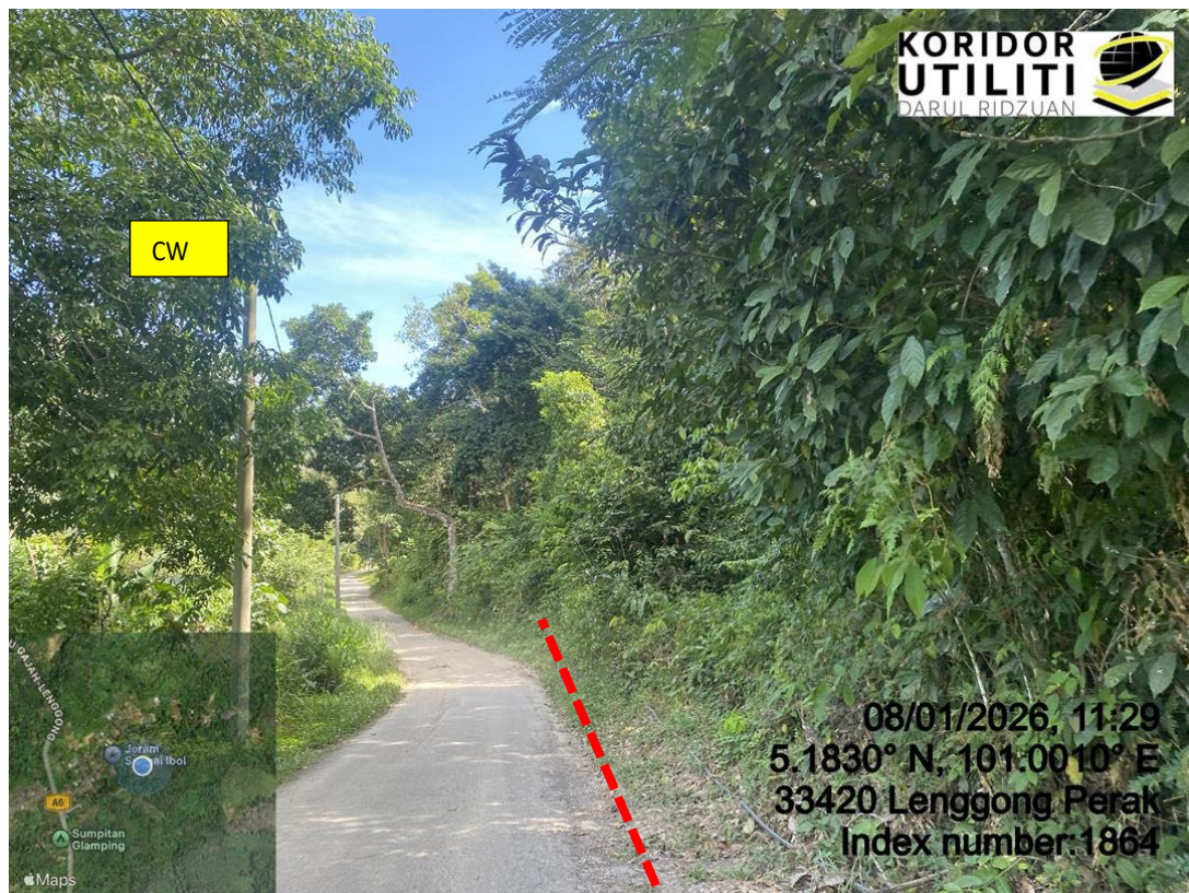
LOKASI DI JALAN KAMPUNG AIR IBOL
