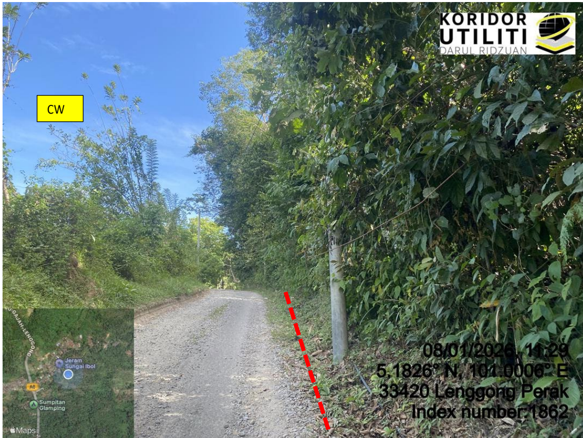
LOKASI DI JALAN KAMPUNG AIR IBOL
