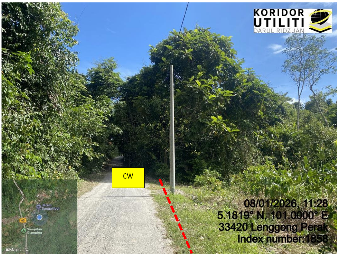
LOKASI DI JALAN KAMPUNG AIR IBOL
