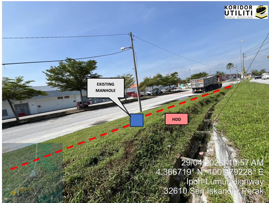
JAJARAN KERJA HDD DI LEBUHRAYA IPOH – LUMUT (FT.05) (SAMBUNGAN EXIST MH 3 KE EXIST MH 4 DI SEMPADAN KINTA – PERAK TENGAH)
