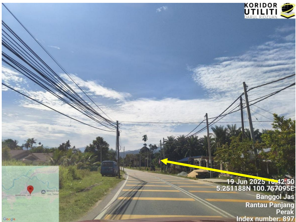
CADANGAN HDD DI JALAN JKR
