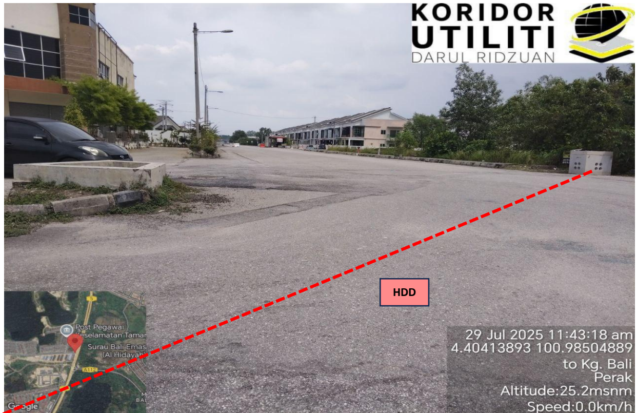
LOKASI KERJA-KERJA KOREKAN HDD TERBUKA DI JALAN MASUK TRONOH AKASIA
