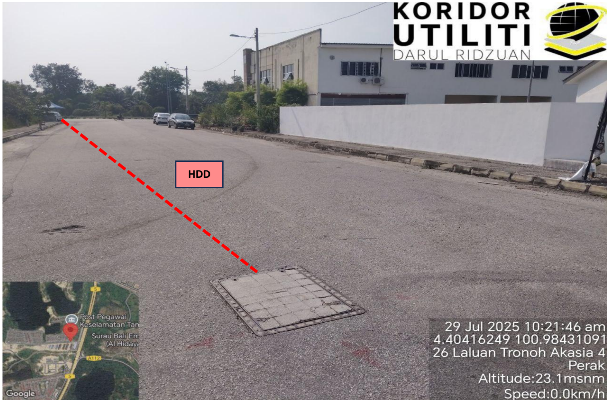
LOKASI KERJA-KERJA HDD KOREKAN TERBUKA DI JALAN MASUK TRONOH AKASIA
