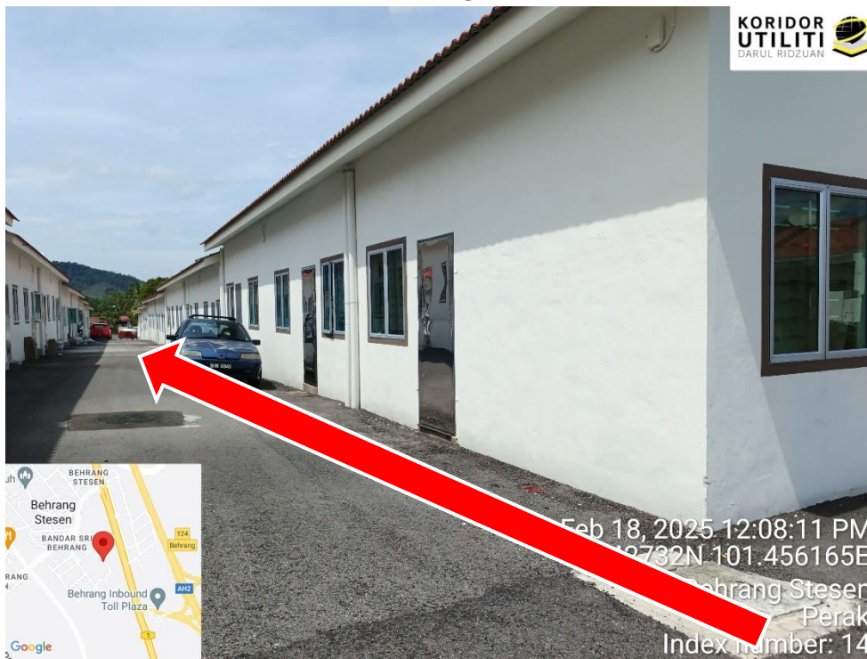
LOKASI DI ANTARA BANGUNAN DI JALAN SENTRAL 6 DAN JALAN SENTRAL 7, LALUAN PENANAMAN TIANG
