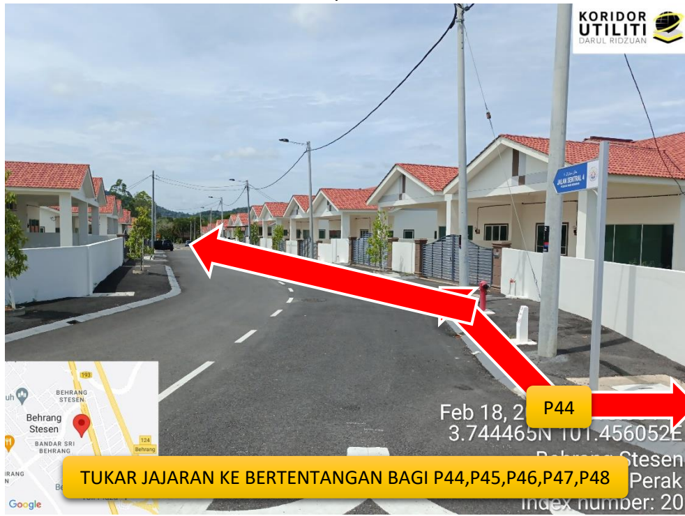
LOKASI DI JALAN SENTRAL 4, LALUAN PENANAMAN TIANG
