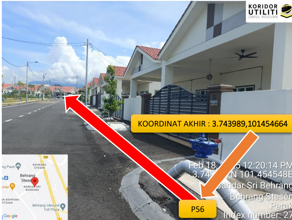
LOKASI DI JALAN SENTRAL 3, LALUAN PENANAMAN TIANG
