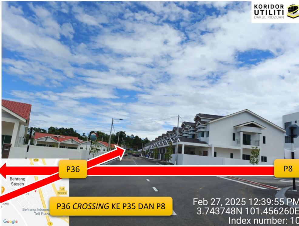
LOKASI DI JALAN SENTRAL 2, LALUAN PENANAMAN TIANG
