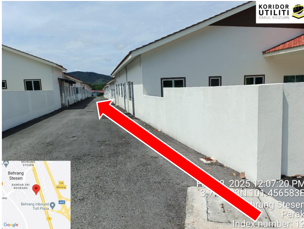
LOKASI DI ANTARA BANGUNAN DI JALAN SENTRAL 8 DAN JALAN SENTRAL 7, LALUAN PENANAMAN TIANG
