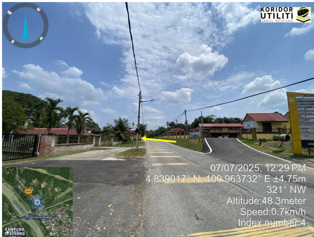
CADANGAN HDD DI JALAN JKR
