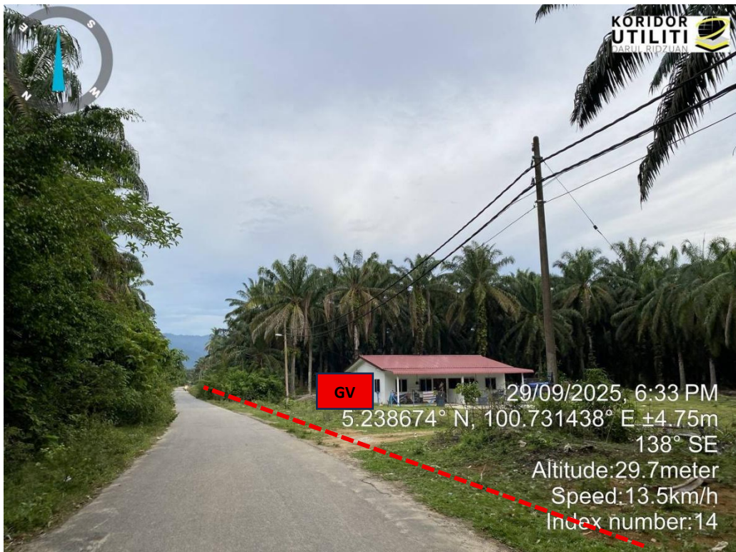
CADANGAN KOREKAN JALAN TIDAK BERTURAP (GV) DI KAMPUNG BUKIT TORAK (PDT)
