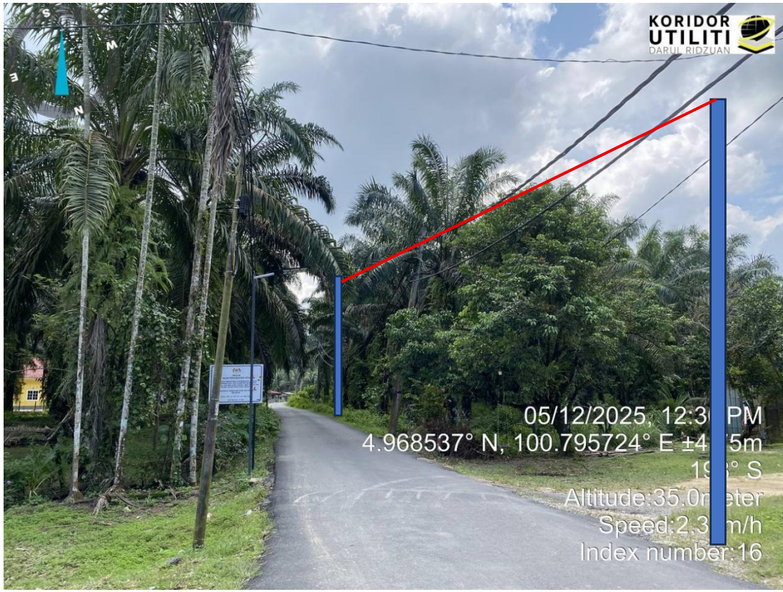
CADANGAN PENANAMAN TIANG DI JALAN KAMPUNG BECHAH (JALAN PDT)
