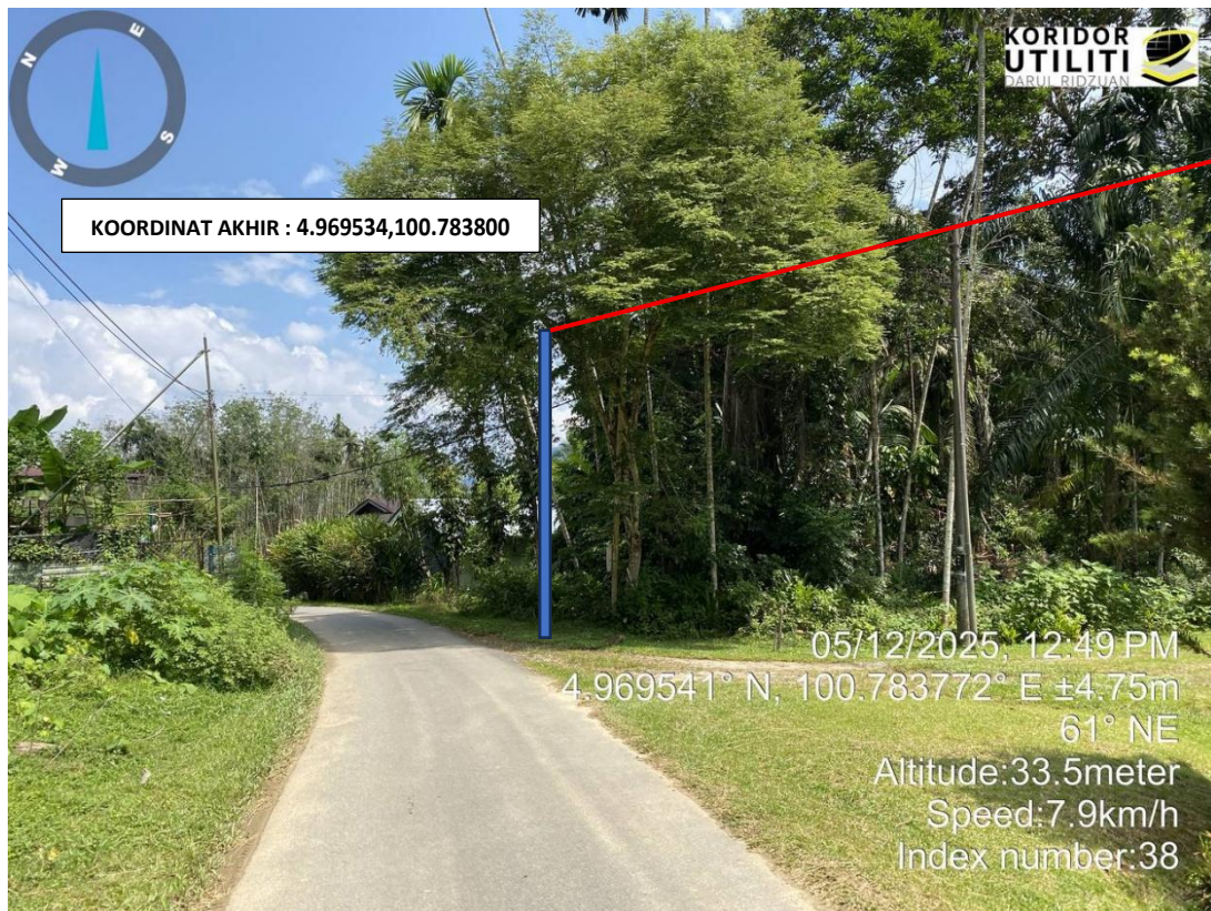
KOORDINAT AKHIR – CADANGAN PENANAMAN TIANG DI JALAN CHANGKAT LOBAK (JALAN PDT)
