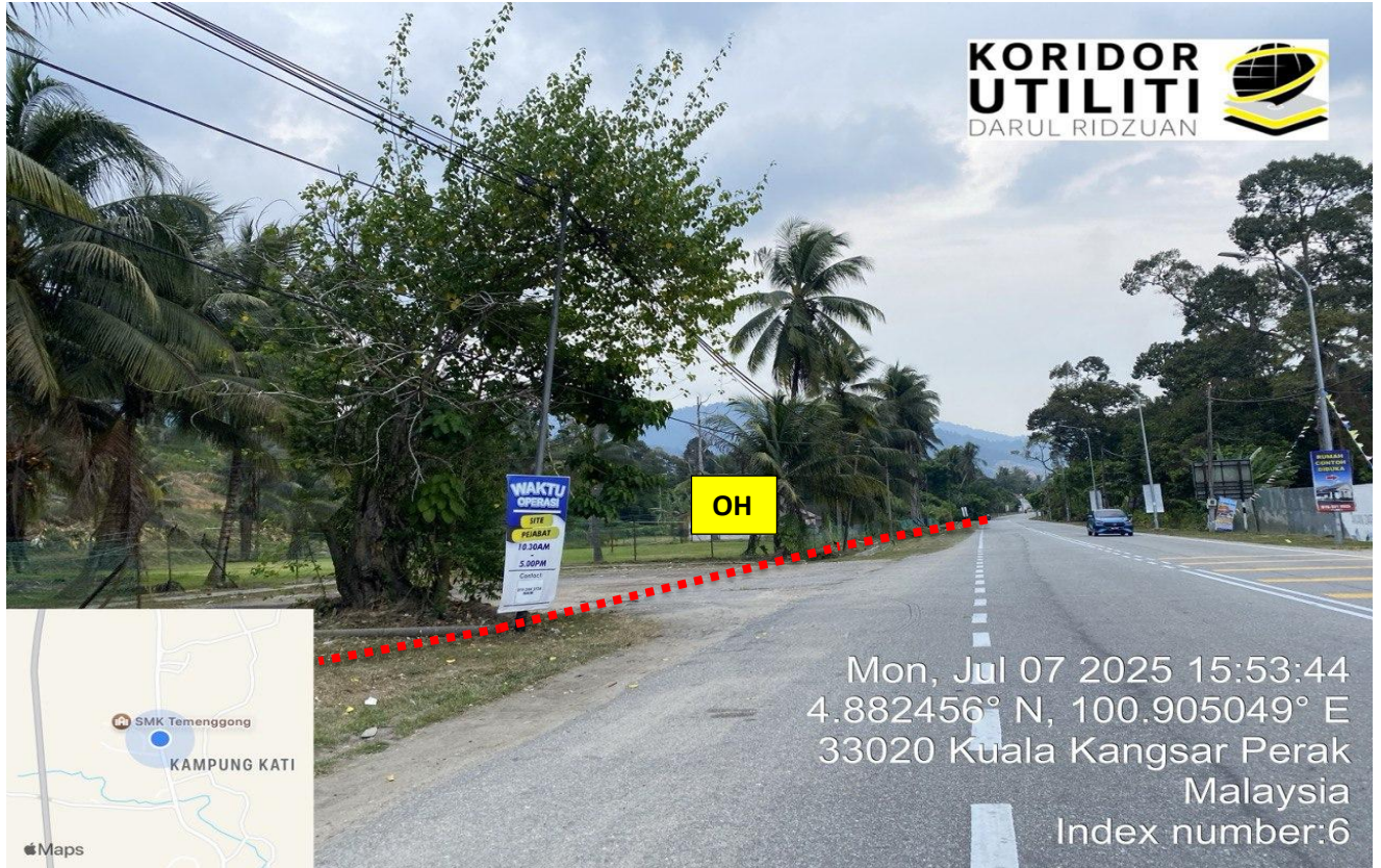
LOKASI DI JALAN LAMA PEKAN KATI (A011)
