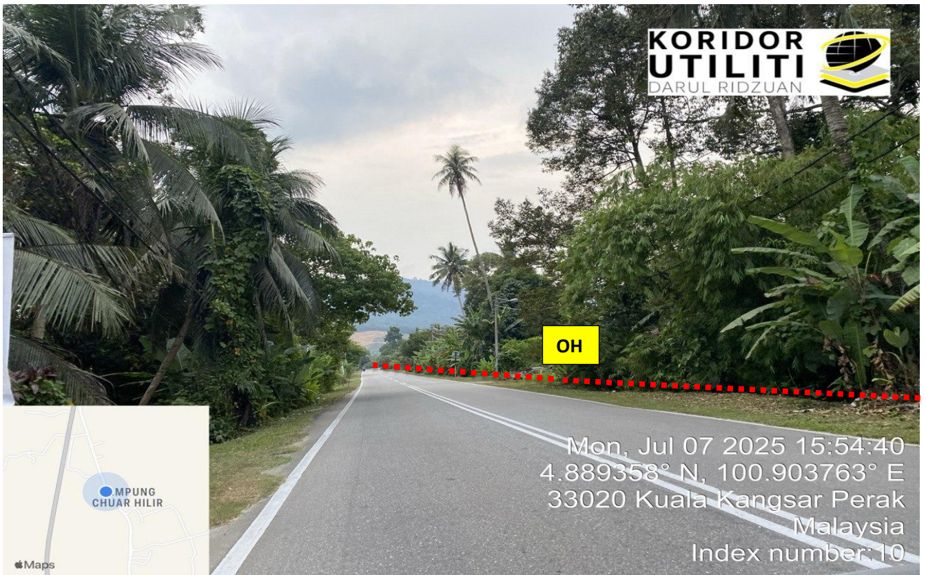
LOKASI DI JALAN LAMA PEKAN KATI (A011)
