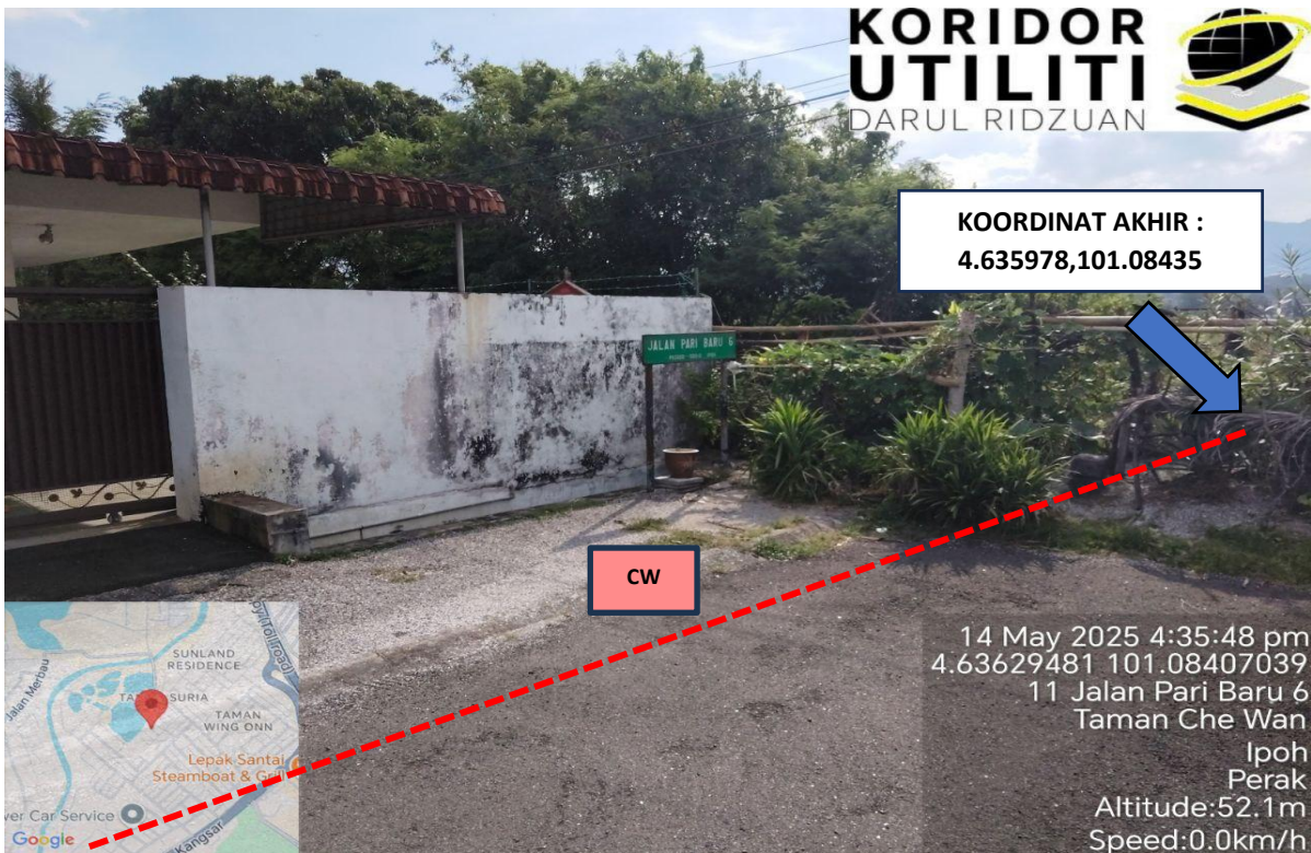
LOKASI A KERJA KOREKAN TERBUKA JALAN PARI BARU 6
