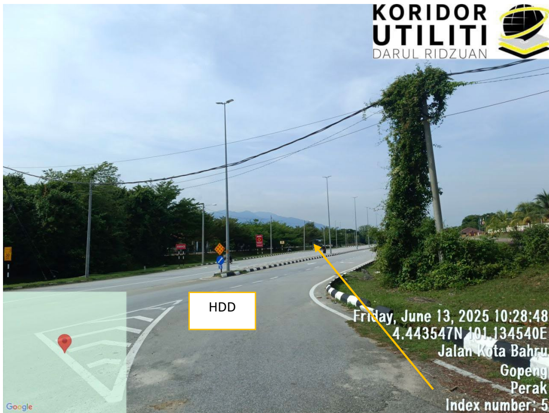
KAEDAH HDD CROSSING JALAN KOTA BAHARU (A110)
