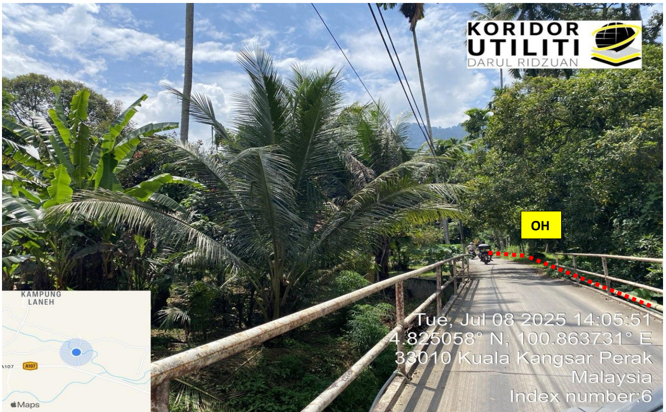
LOKASI DI JALAN HAJI ALANG AHMAD
