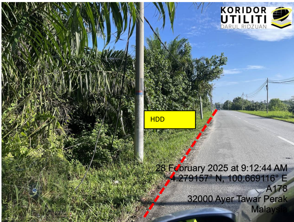
LOKASI DI JALAN KAMPUNG BARU
