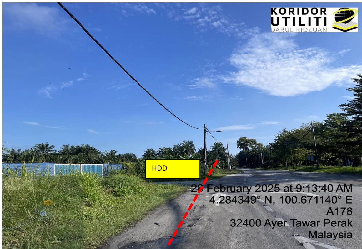
LOKASI DI JALAN KAMPUNG BARU
