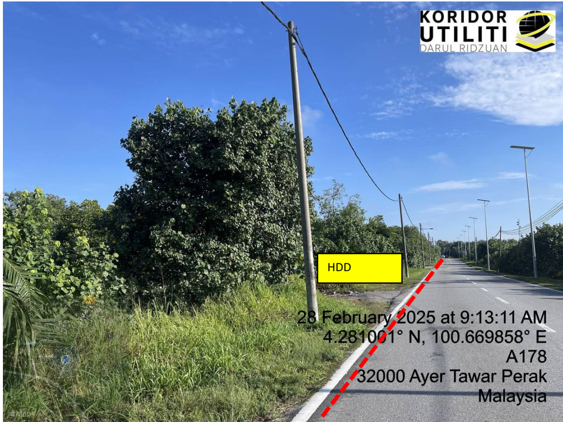
LOKASI DI JALAN KAMPUNG BARU
