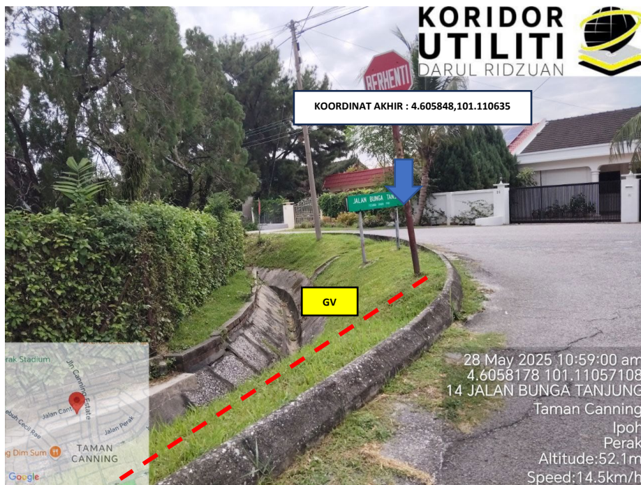
LOKASI KOORDINAT B AKHIR KOREKAN TERBUKA DI JALAN BUNGA TANJUNG
