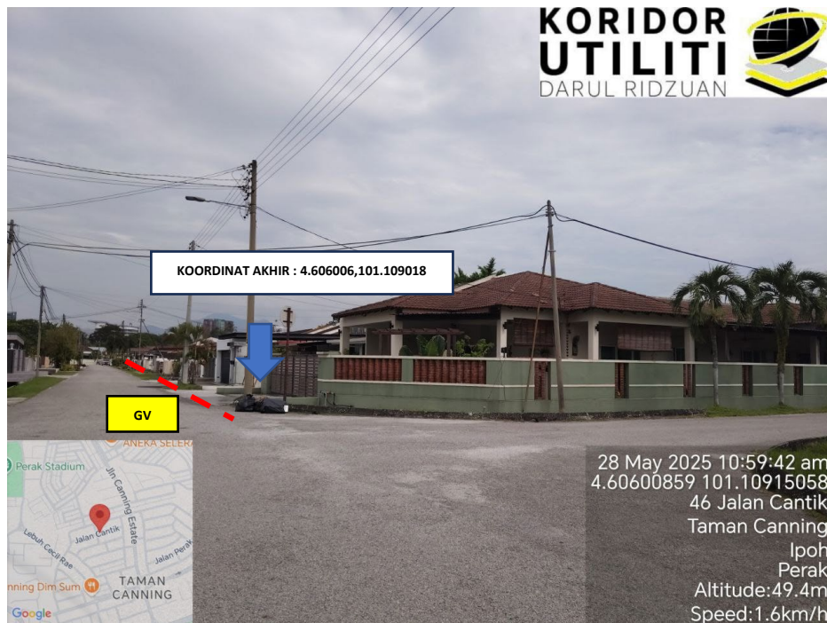
KOORDINAT AKHIR A KOREKAN TERBUKA DI JALAN CANTIK
