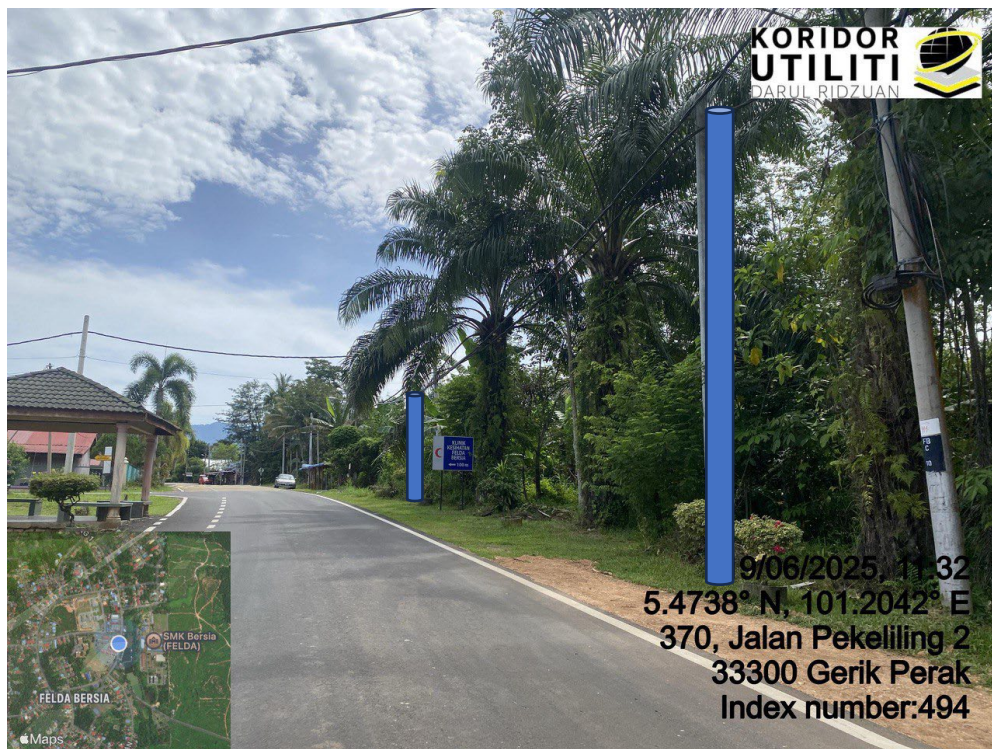
LOKASI DI JALAN FELDA BERSIA
