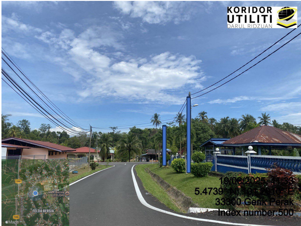
LOKASI DI JALAN FELDA BERSIA
