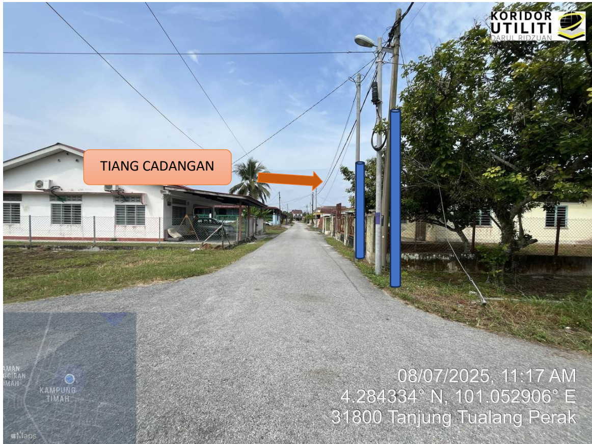
LOKASI JAJARAN TIANG CADANGAN DI SEKOLAH JENIS KEBANGSAAN (CINA) KAMPONG TIMAH
