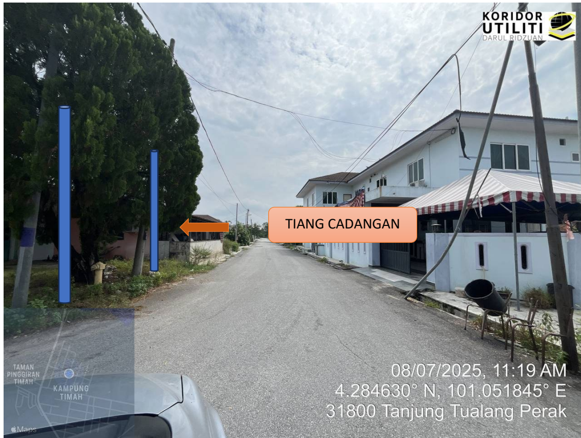
L LOKASI JAJARAN TIANG CADANGAN DI SEKOLAH JENIS KEBANGSAAN (CINA) KAMPUNG TIMAH
