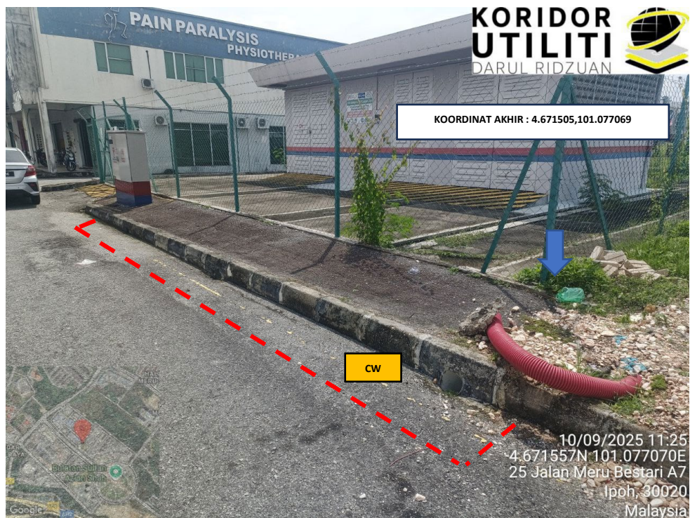
LOKASI KOORDINAT AKHIR KOREKAN TERBUKA DI JALAN MERU BESTARI A7
