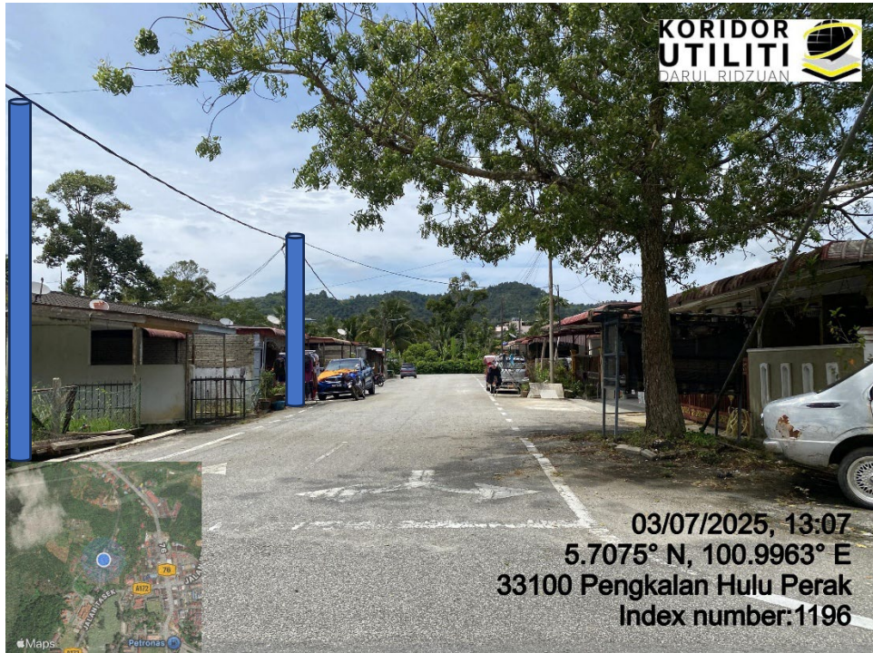
LOKASI DI JALAN TAMAN DATO' LAM KOK LONG
